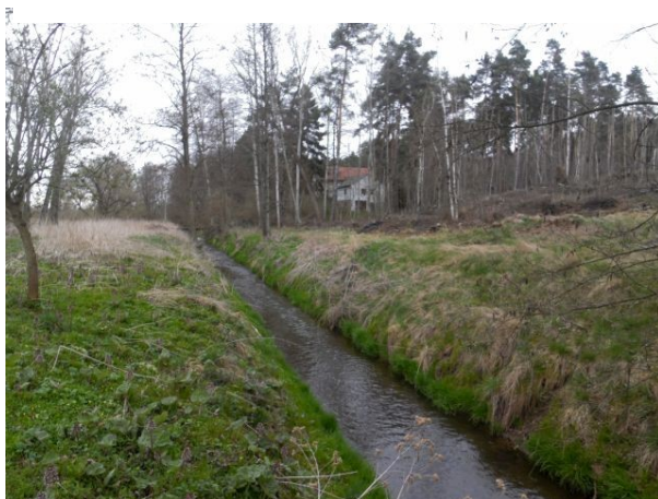
Obr. 44: Koryto v úseku LIS019
