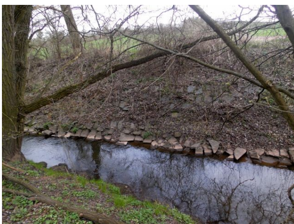
Obr. 50: Břehová úprava v úseku LIS016
