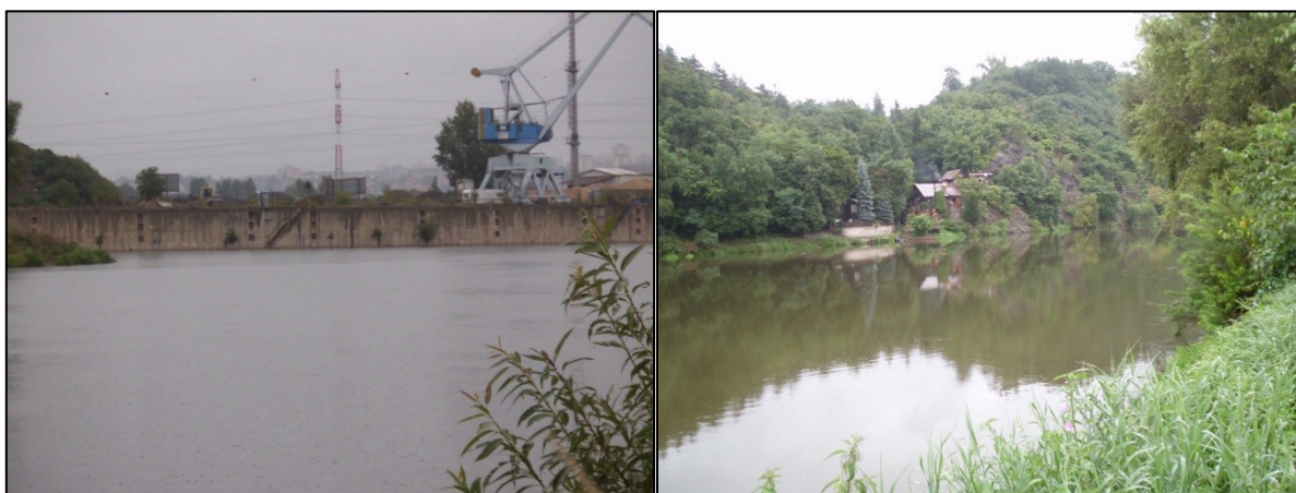
Obr. 36: vlevo- zpevnění břehu betonovou zdí (BER002), vpravo – prakticky nulová niva na levém břehu (BER014)
