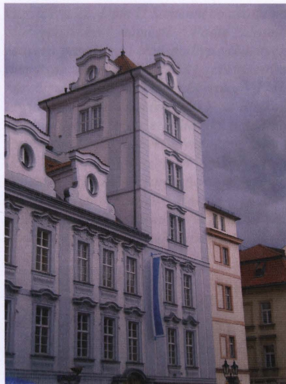
Obr. 19. Dům v Rytířské ulici č. p. 403 na Starém Městě s raně gotickou věží. Současný stav. Foto archiv autora.
