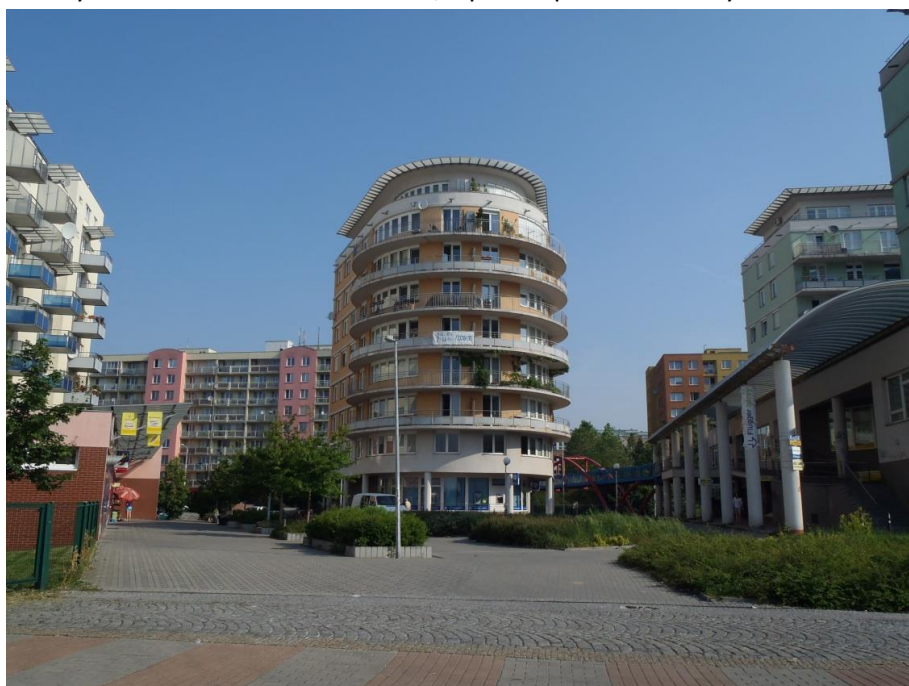
Obrázek 6: Nová výstavba na Slunečním náměstí, v pozadí panelové domy z konce 90. let
