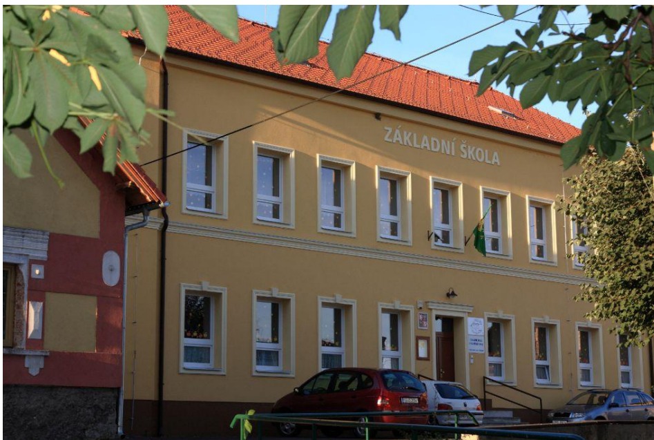
Obr. č. 1: Základní škola Dolní Hbity
