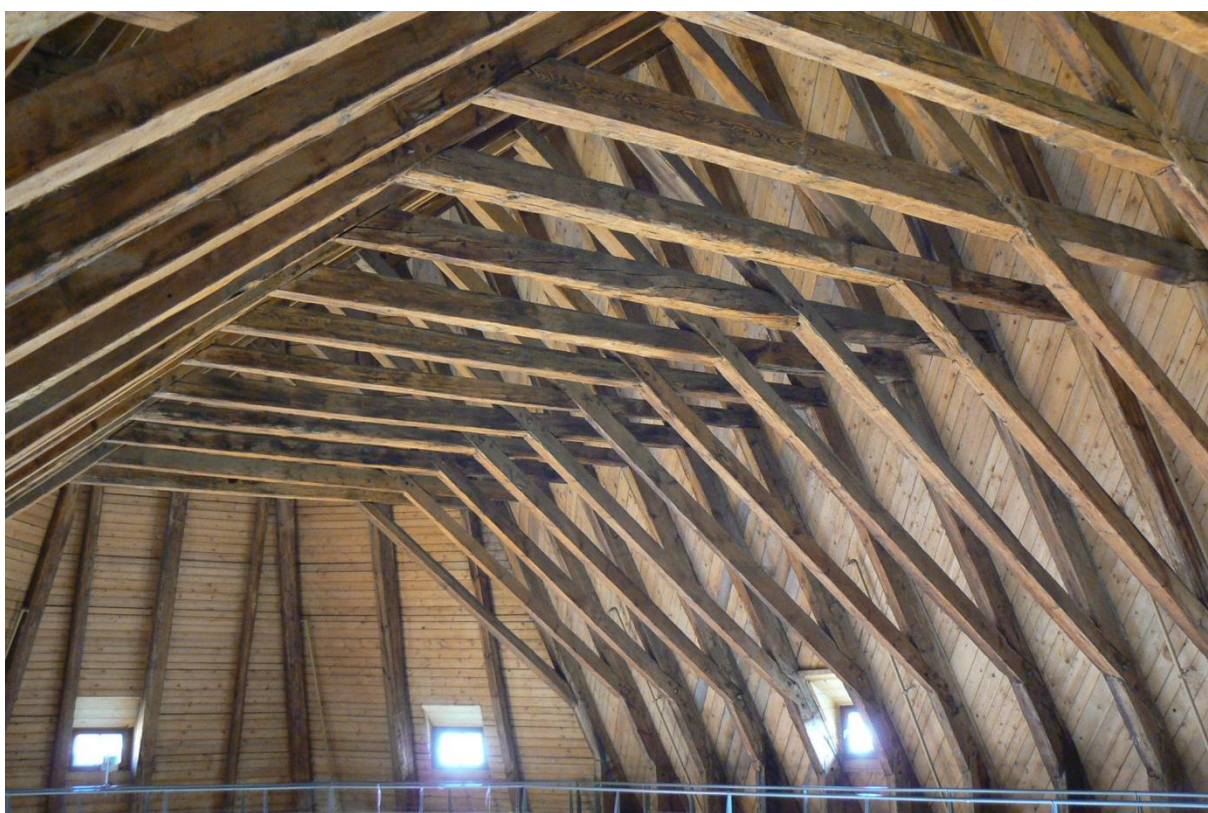
19. Středověký krov, detail, interiér kostela sv. Anny
