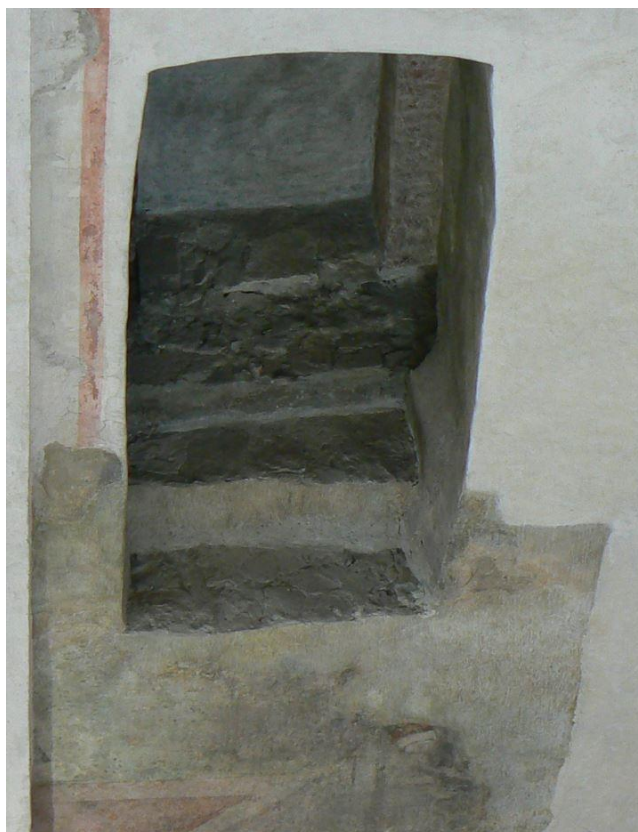
10. Kostel sv. Anny , interiér, vchod na úrovni empory, pohled z krovu, jižní stěna presbytáře
