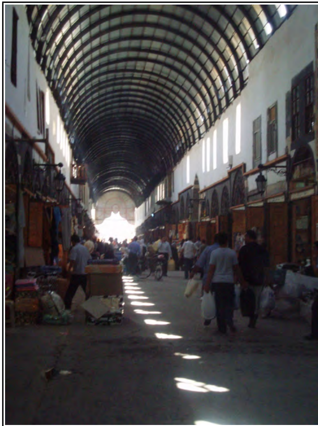
30. Súq Midhat Paša po renovaci v roce 2008
