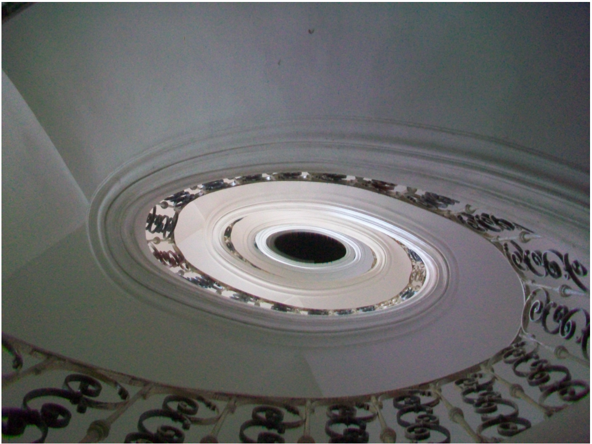
4. Šnekové schodiště, J. B. Santini-Aichel, jihozápadní křídlo konventu v Plasích. Foto: Pavel Beneš
