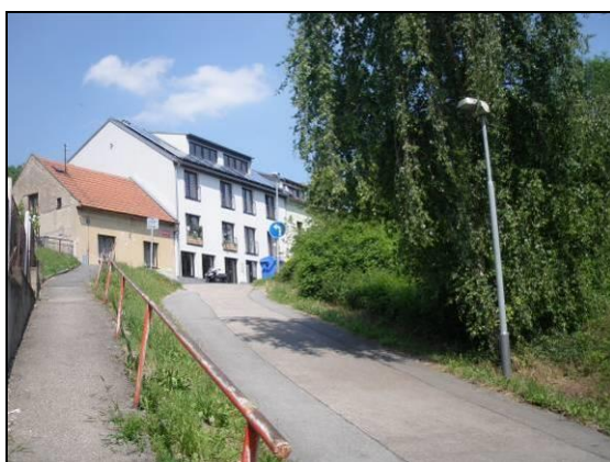
Obr. č. 26.: pohled ze západu na zavážkou setřený objekt 4
