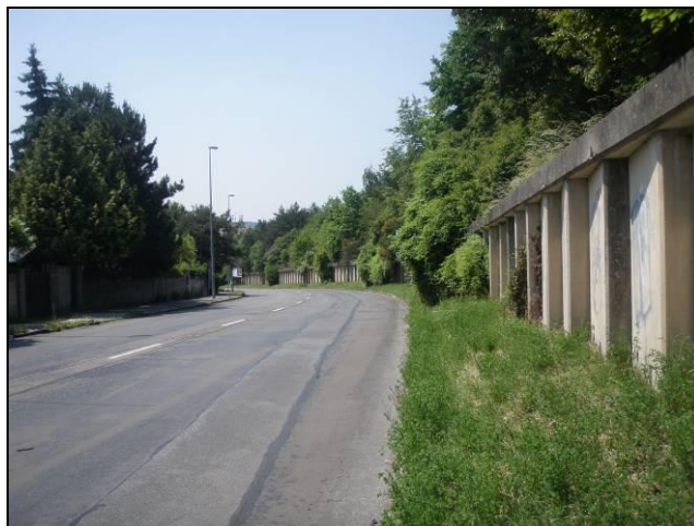
Obr. č. 18. : prefabrikovaná opěrná zeď v ulici Pod stadiony
