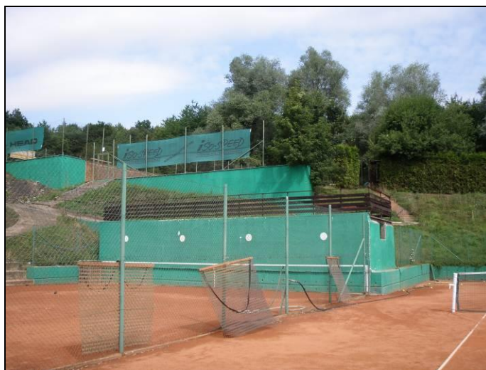
Obr. č. 15.: pohled z jihu na sanaci sesuvu 5841 stavbou tenisových kurtů a vysvahováním
