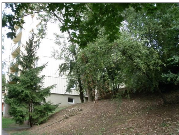
Obr. č. 43.: pohled na panelový dům stojící na místě hlinišťe
