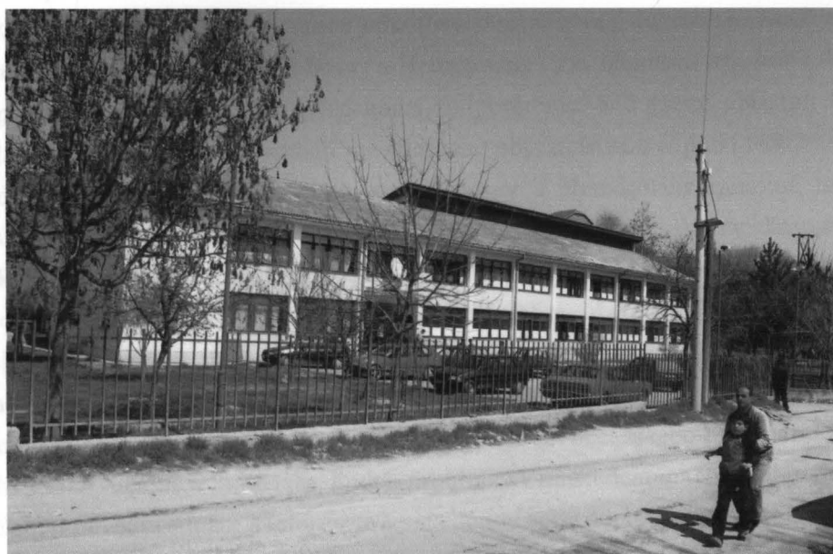
Obr. 11 –Medresa Isa-beg v Kondovu u Skopje
