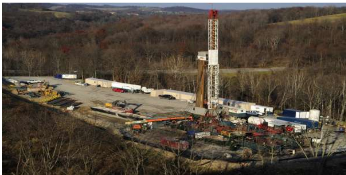
Obr. 3 Vrtná základna s vrtnou věží, Marcellus Shale, USA (Zdroj : http://energetika.tzb-info.cz/vytipime-plynem/12610-bridlicovy-plyn-tezba )
