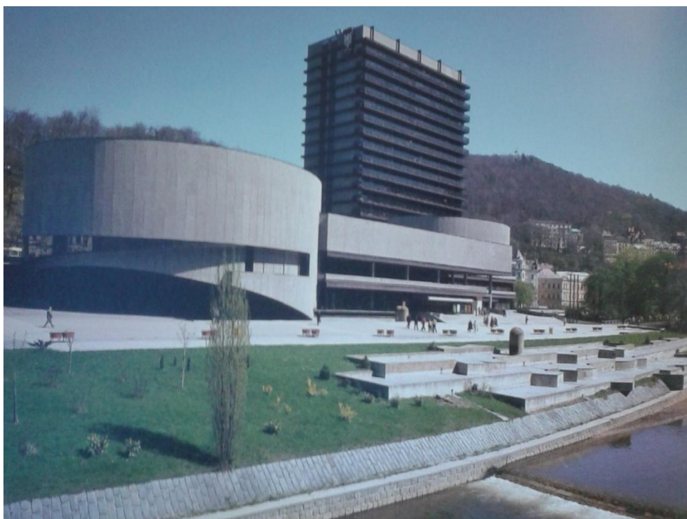
Obrázek 8: Hotel Thermal, pohledn z jihu – hmota velkého sálu, podnož a věž (od řeky vede kaskáda), 70. a 80. Léta.
