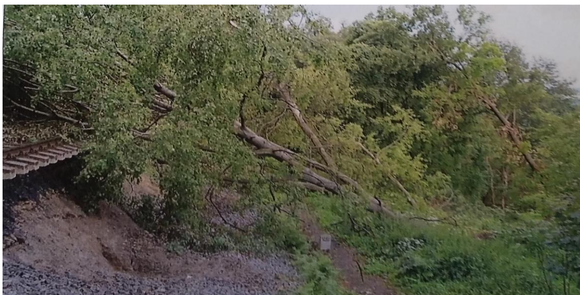
Obrázek 3 Odlučná oblast sesuvu na trati Liberec – Česká lípa. Zdroj: Vojtěchovská et al., 2013.
