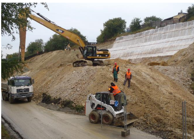
Obrázek 16 Prováděné sanační práce. Zdroj Kycl 2011
