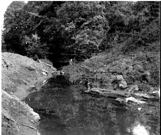
Obrázek 5 Zavalené koryto řeky Olešky. Zdroj: Rybář, Pašek 1975.
