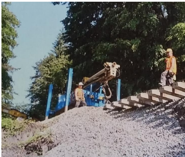
Obrázek 4 Vrtné práce nad severovýchodní odlučnou oblastí sesuvu. Zdroj: Vojtěchovská a další 2013
