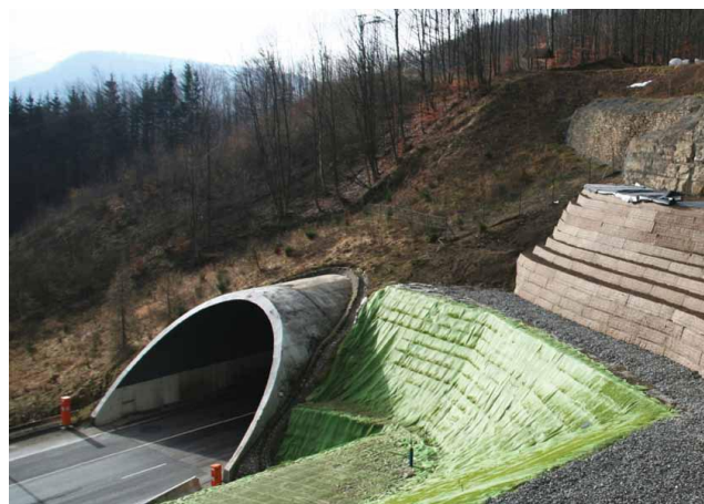
Obrázek 8 Pohled na portál tunelu a vystavěnou přítěžovací a ochranou lavici. Zdroj: http://www.arcadis.cz/Projects
