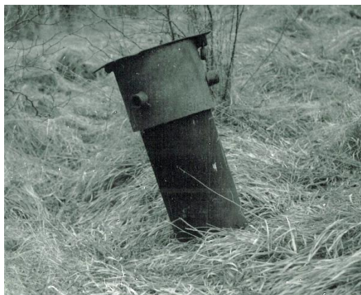
Obrázek 12 Původně svislý odvodňovací vrt z roku 1970. Zdroj: Rybář, 1983
