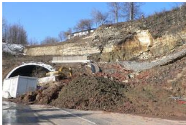
Obrázek 7 Čelo vzniklého sesuvu zahrazující portál tunelu. Zdroj: http://www.casopisstavebnictvi.cz/
