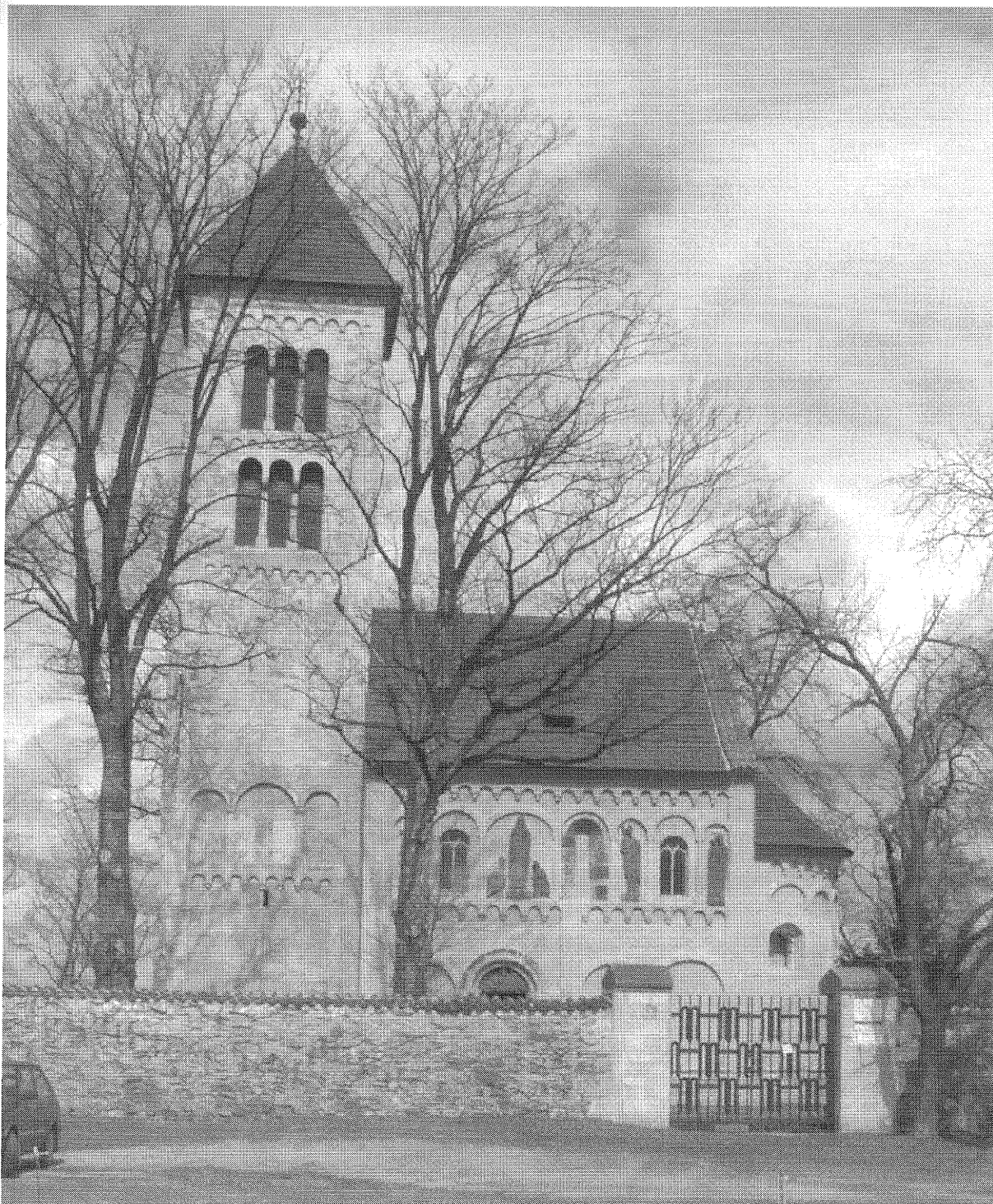
8) Kostel sv. Jakuba. Pohled na jižní průčelí kostela.
