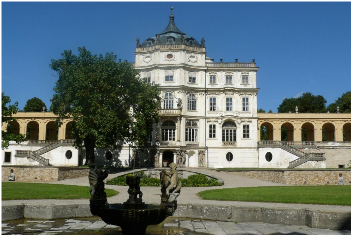
16. Zámek Ploskovice, celkový pohled od jihu
