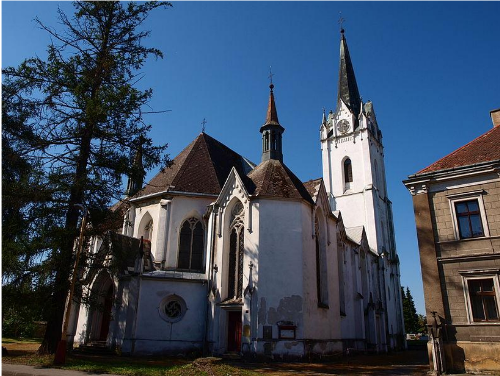
11. Kostel svatého Fabiána a Šebestiána v Zákupce, novogoticky přestavěn na náklady Ferdinanda V. Dobrotivého
