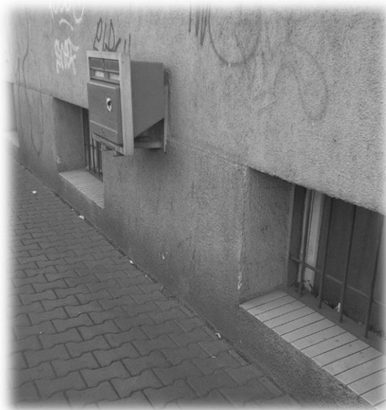
Obr. 9 Překážka přes vodící linii 3, zdroj: autorka
