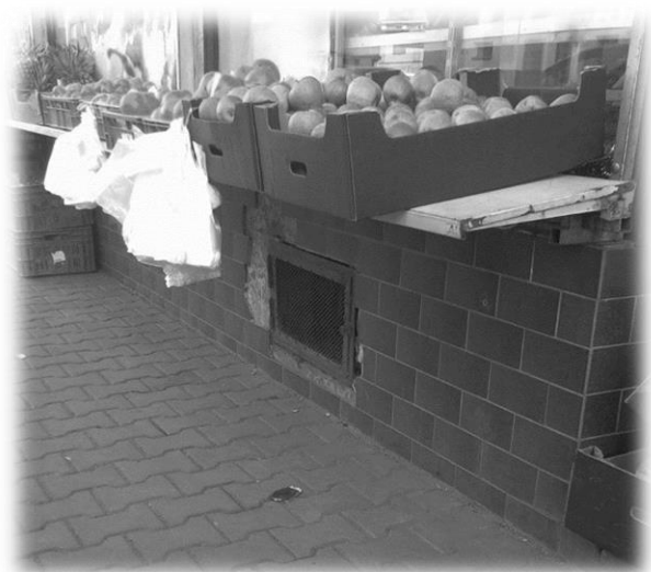
Obr. 8 Překážka přes vodící linii 2, zdroj: autorka
