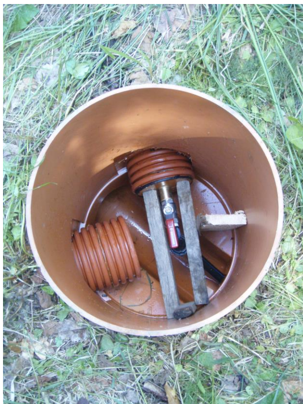
Obr. 21: Instalace víčka v revizní šachtě Schindlerova pramene, Foto: Viktor Goliáš
