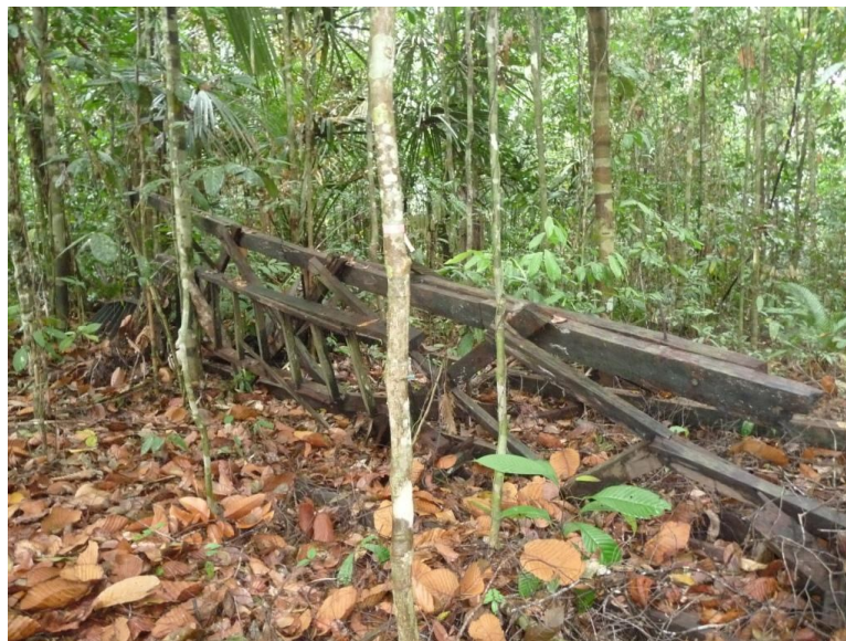
Obr. 19: Trouchnivějící torzo vyhlídkové věže
