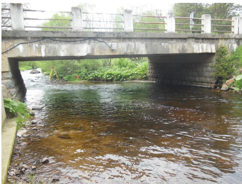
Obr. 6.4: Profil na Křemelné s měřicím čidlem (foto autor)
