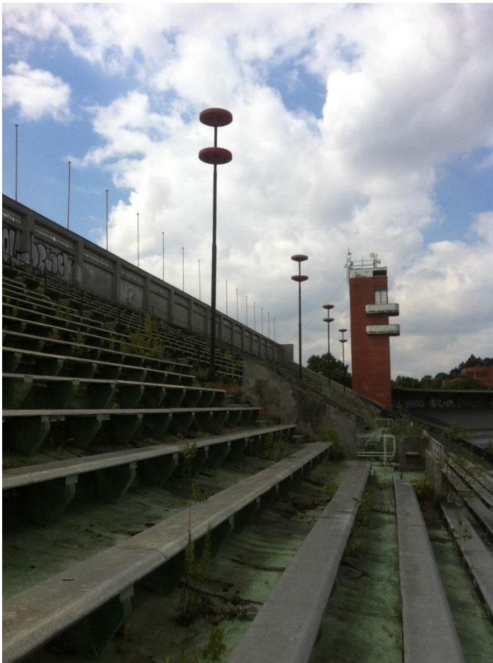
Obr.63: Karel Kopp / Ferdinand Balcárek: Velký strahovský stadion, věže pro reportéry, Praha, 1933 – 1934, současný stav
