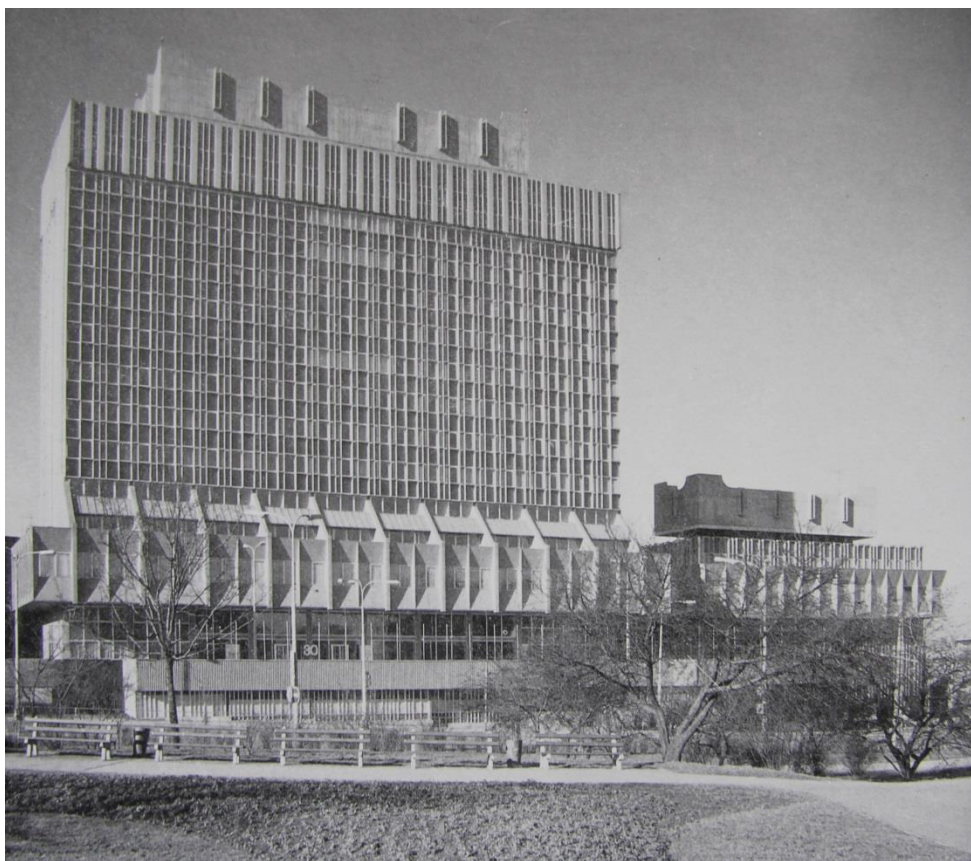
Obr.15: Václav Hilský / Otakar Jurenka: administrativní budova Centrotex, Praha, 1972 až 1978, dobový snímek
