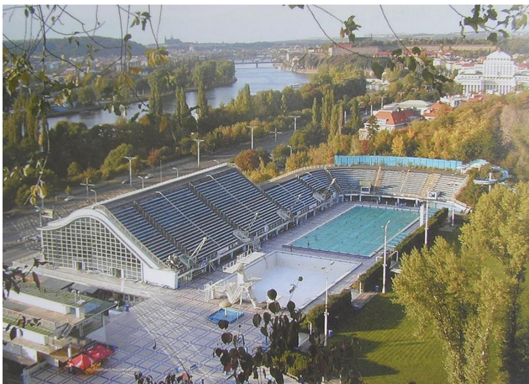
Obr.2: Richard Podzemný: Plavecký stadion v Praze Podolí, 1960-1965, celkový pohled na současný stav
