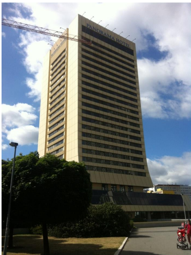
Obr.52: Alois Semela: Hotel Panorama, Praha, 1981 – 1983, pohled na fasádu, současný stav
