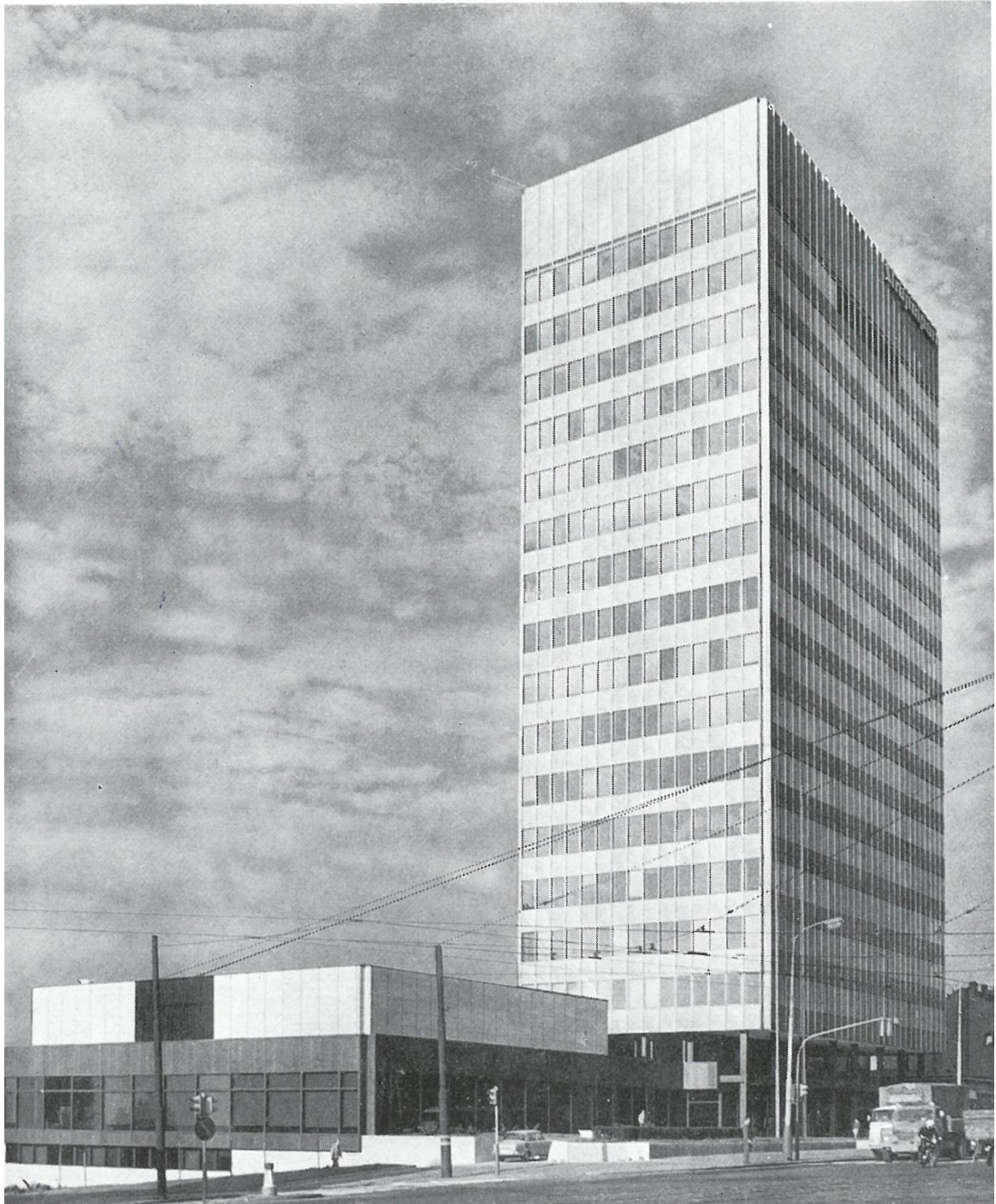
Obr.21: Zdeněk Kuna / Olivier Honke-Houfek / Zdeněk Stupka: Strojimport, Praha, 1961 - 1971, pohled na severní a západní fasádu na dobovém snímku
