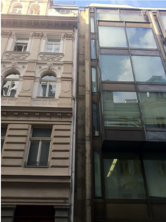
Obr.90: Zdeněk Kuna / Zdeněk Stupka / Milan Valenta / Jaroslav Zdražil: Administrativní budova podniku zahraničního obchodu Omnipol, Praha, 1974 až 1979, napojení na okolní zástavbu
