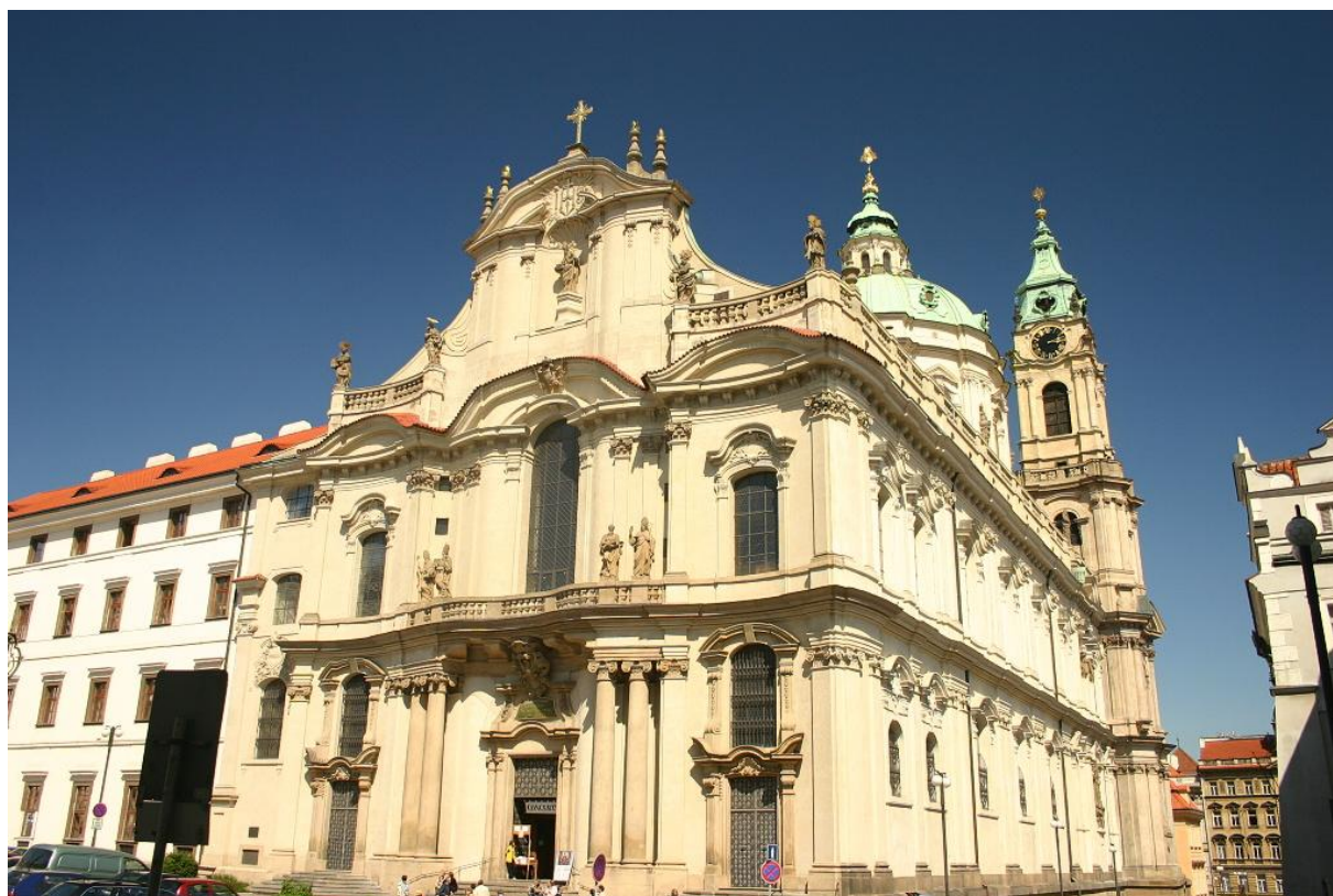
Obr. 26 Kostel sv. Mikuláše, hlavní průčelí
