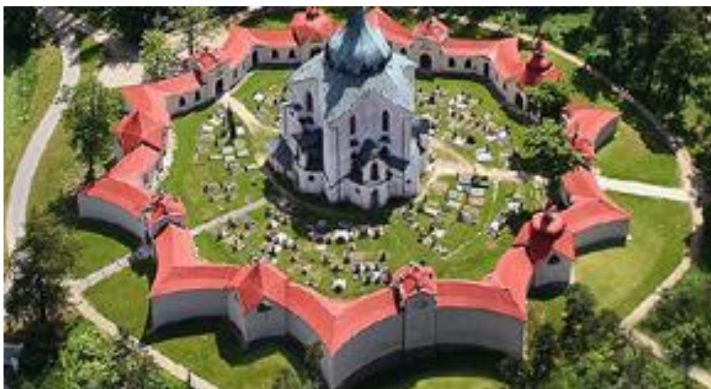
Obr. 23 Kostel Jana Nepomuckého na Zelené Hoře ve Žďáru nad Sázavou, architekt Santini
