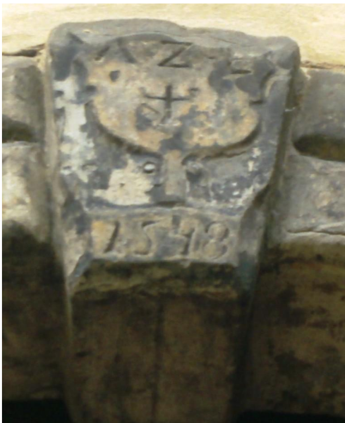
Detail svorníku nad průčelím s iniciálami „AZL 1548“.
