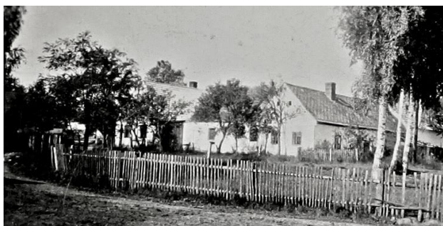
Obr. č. 1 – Rodné stavení v Kojákovících (1913).
