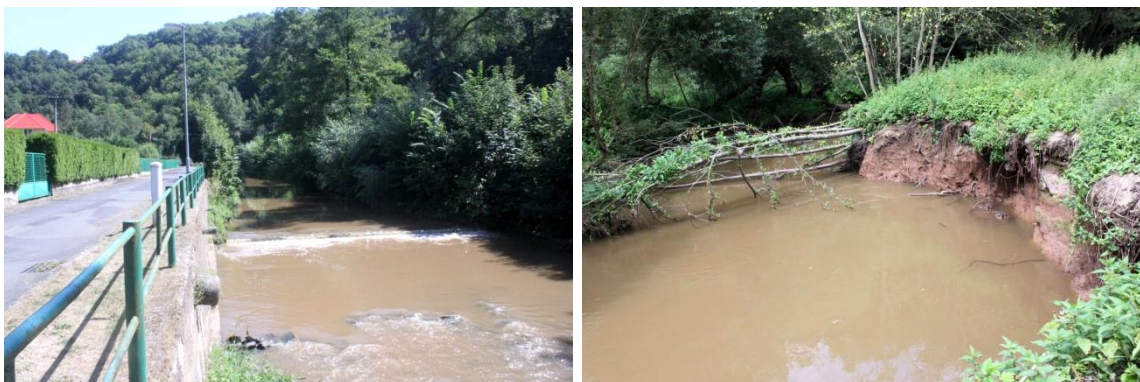
Foto 5 (vlevo) Břeh zpevněný betonem v úseku RAK004.
