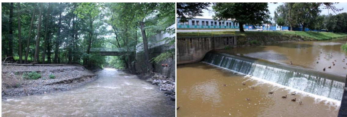
Foto 5 (vlevo) Omezená průchodnost nivy z důvodů dopravní komunikace vedoucí v těsné blízkosti koryta toku v obci Křivoklát (RAK002).
