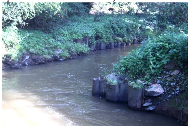
Foto 7 Nevhodně provedená úprava břehů v úseku RAK011.
