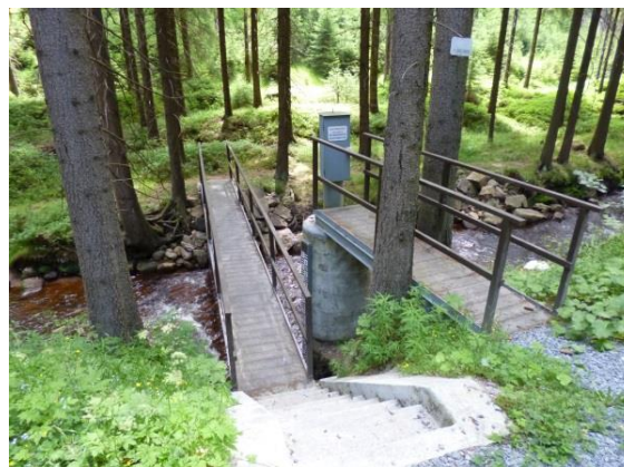
Obr. 7.15: ROL044 - stanice Chaloupky (foto autor)
