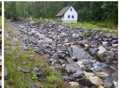
Obr. 7.9: ROL013 - zpevněné břehy (foto autor)
