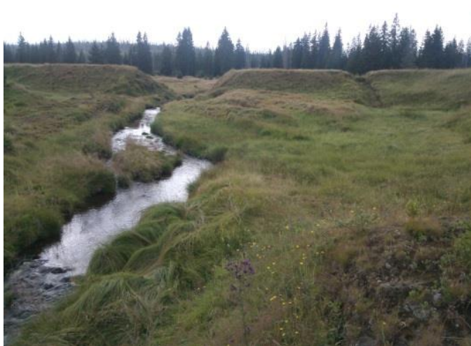
Obr. 7.64: Torza hráze bývalé Roklanské nádrže (foto autor)
