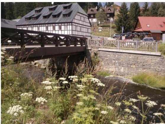
Obr. 7.61: ROK002 - upravené břehy v obci Modrava (foto autor)
