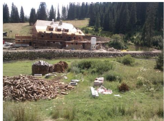
Obr. 7.62: ROK002 - upravené břehy v obci Modrava (foto autor)
