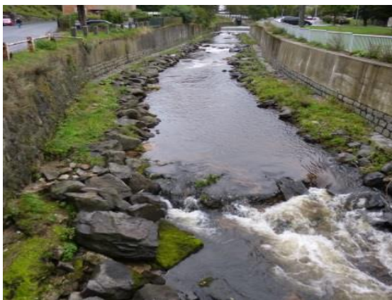
Obr. 7.10: ROL004 - vybetonované břehy v obci Nejdek (foto autor)
