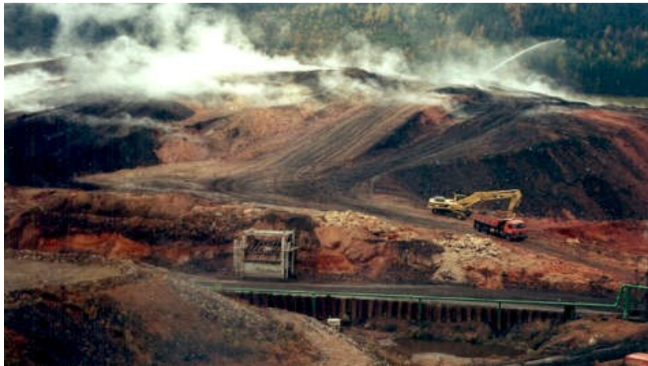
Obr. 7. Sanace odvalu v Radvanicích. Asi kolem roku 1990 (zdroj: www.zdarbuh.cz ).
