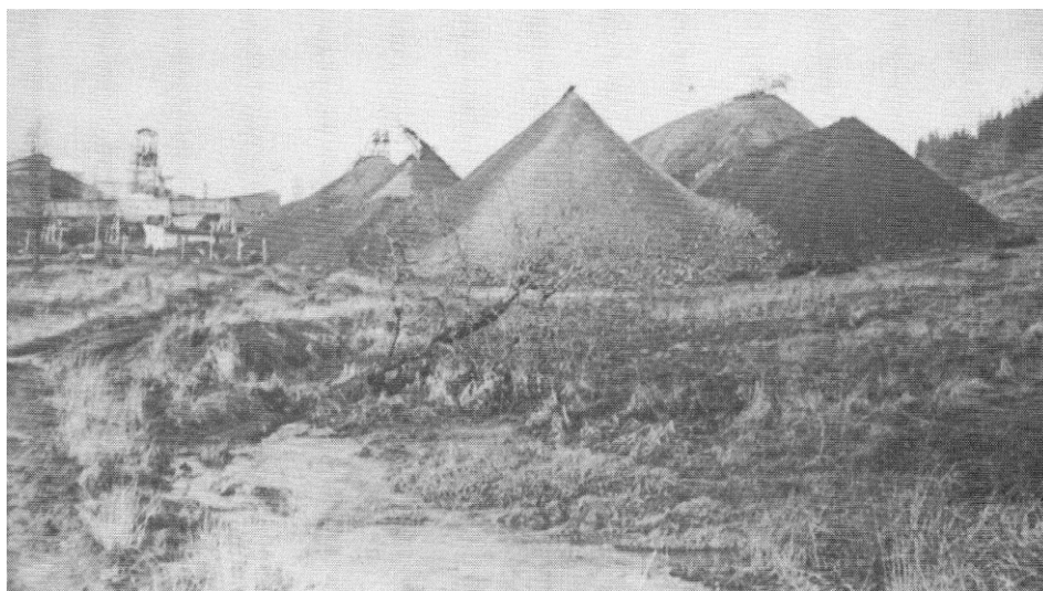
Obr. 14. Odvaly jámy č. 3 u Rybníčku v roce 1956 (zdroj: Cimala 1997).
