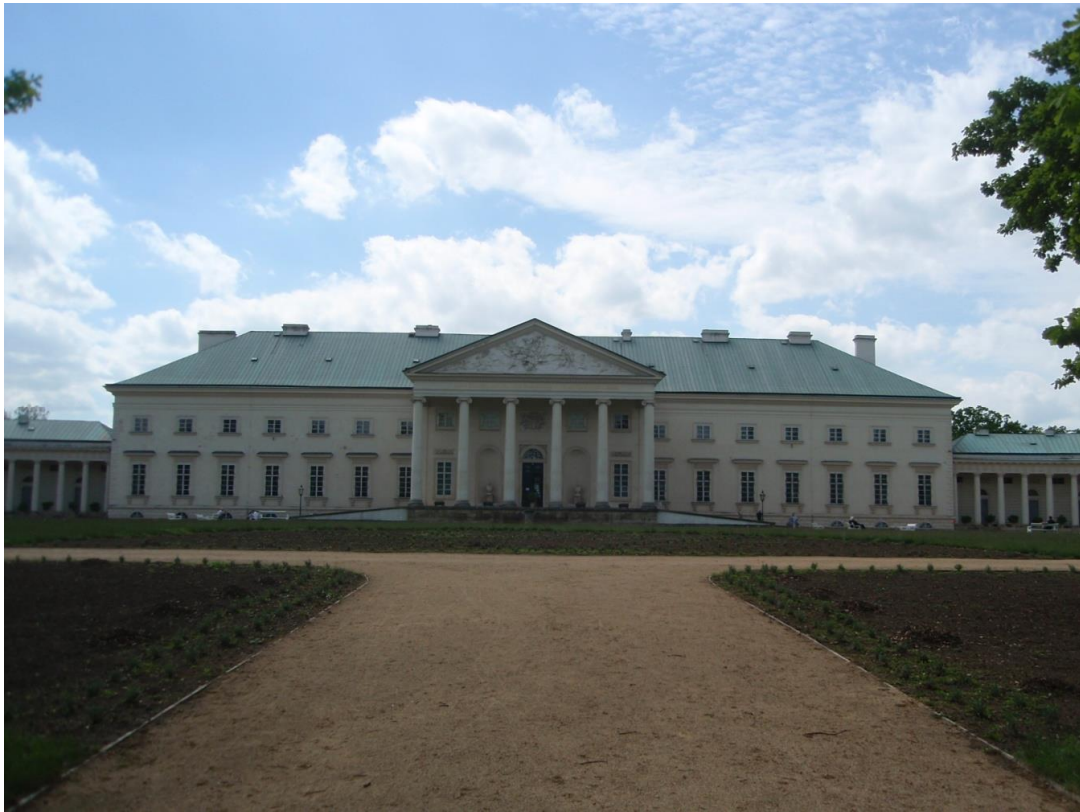
Příloha .15: Zámek Kačina, průčelí hlavní budovy
