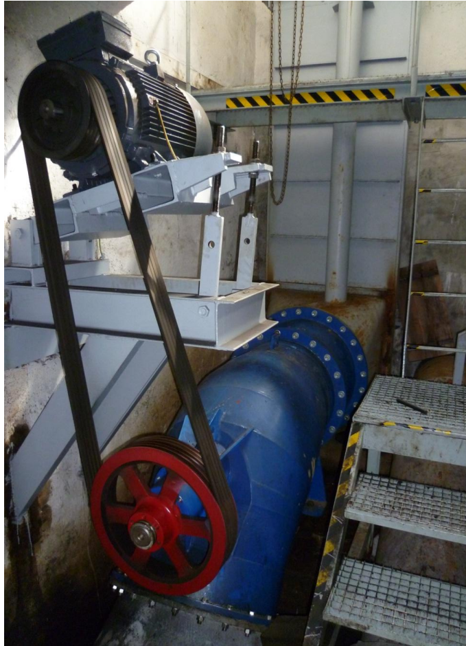
Obrázek 3.6: Turbína a generátor MVE Brozany
