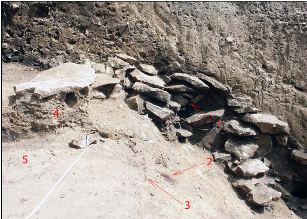
Obr. 25: Detail profilu V sondy 2004. 1 – líc čelní kamenné plenty, 2 – hák, 3 – podélné břevno, 4 – násep ze štěrkopísku a spraše, 5 – povrch podkladu pro základ čelní kamenné plenty.
