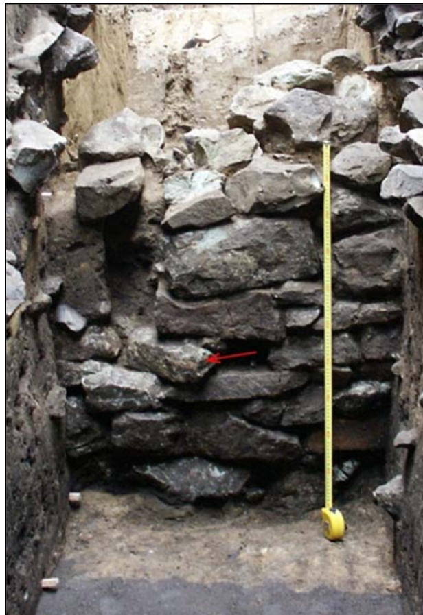
Obr. 16: Zahrada divadla 2003. Čelní kamenná penta starší/spodní fáze hradby z různě velkých kamenů a bloků pískovce. Šipka označuje kámen vysunutý šikmo vně lince. Vlevo nahoře od něj pravidelný lícovaný otvor vyplněný hutnou světle hnědou hlinou s volně loženými kameny na úrovni koruny penty.
