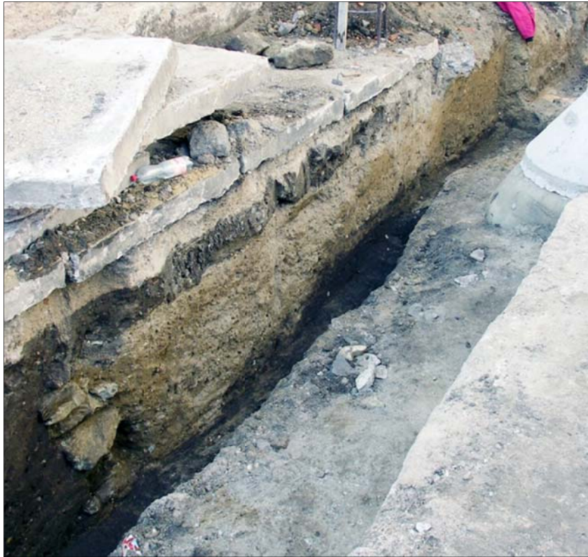
Obr. 13: Výkop kanalizace do hotelu Černý orl 2008. Ven nahnutá čelní kamenná plenta starší/spodní hradby a její šterkopískové jádro bez dokladů vnitřní konstrukce.
