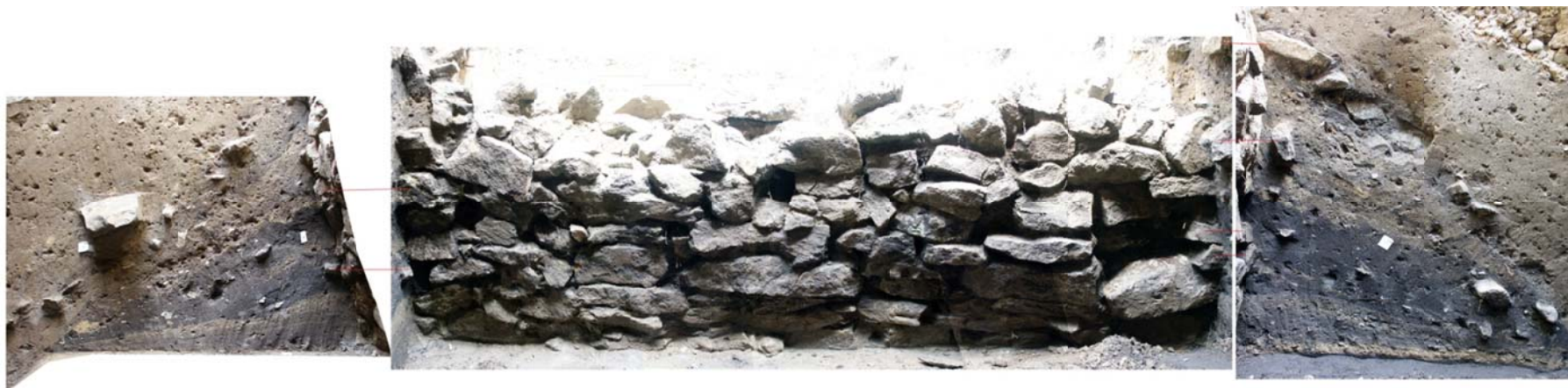
Obr. 6: Zahrada divadla 2004, čelní kamenná plenta spodní/starší hradby. Z čelního pohledu a přiložených bočních profilů je dobře patrné vyklonění hradby ven. Oproti čelním plentám z plochých opukových či pískovcových kamenů precizně poskládaných do řádků hradby na Drahúši (Kotková 2004, Příloha 10: 3), v Levousích (Váňa 1976, Obr. 4) či na Vlastislavi (Váňa 1968, Obr. 13: 2, 16: 1), bylo na stavbu této plenty použito kamenů různé délky, výšky a šířky a především různých tvarů. Plenta je jen z jedné řady kamenů a výzkumem z roku 2003 bylo prokázáno, že kmeny roštu nebyla s plentou provázána. Což by v tomto případě nebylo možné bez toho, aby z ní přečnivala. Vpravo je zjevné statické porušení plenty, které vedlo k jejímu částečnému sesutí. Vrchol plenty není ukončen, ale narušen.
