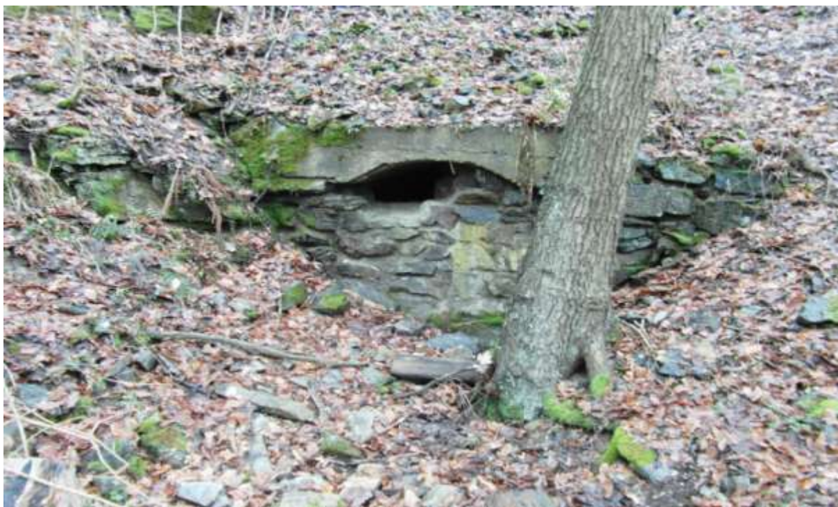
Obr. 30 Pohled na vstup do štolý. Stav v roce 2013.
