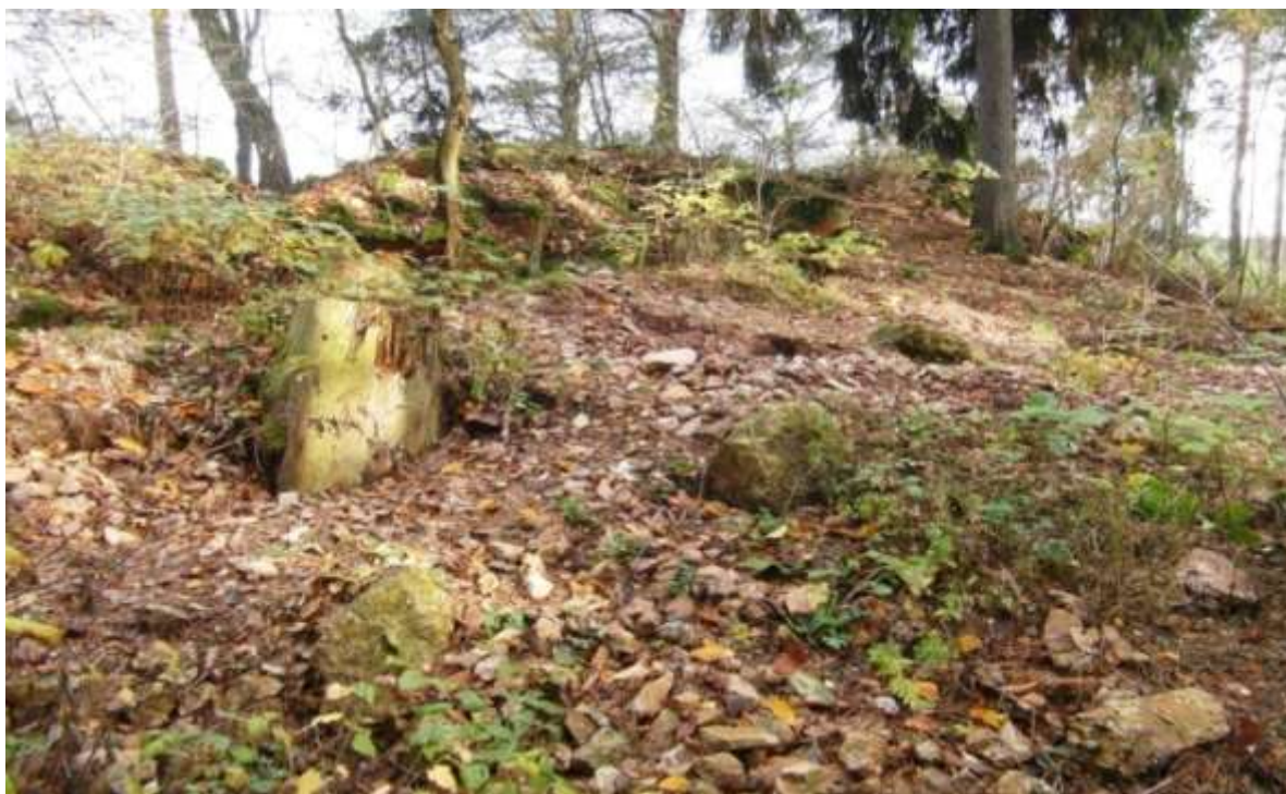
Obr. 34 Pohled na stav haldy na lokalitě Borovina. Rok 2013.
