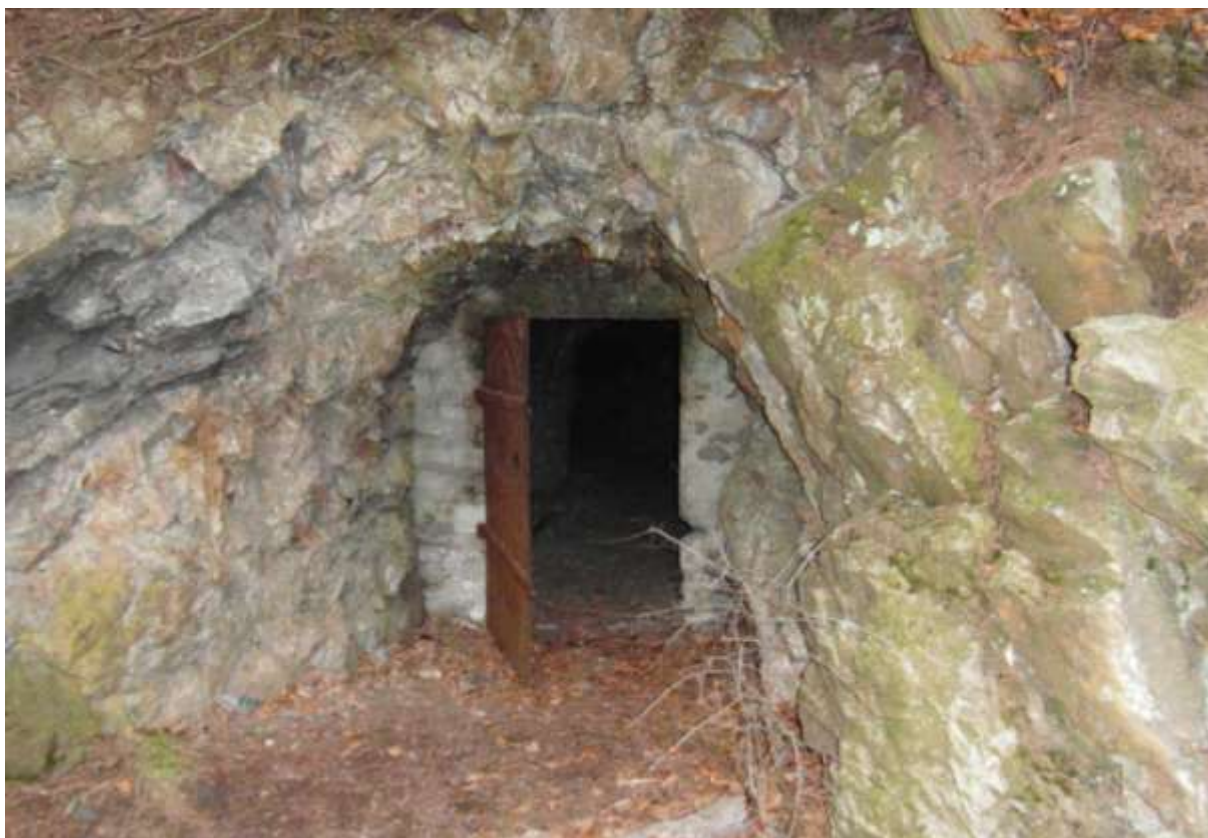
Obr. 51 Pohled na vstup do štoly Mír. Stav v roce 2013.
