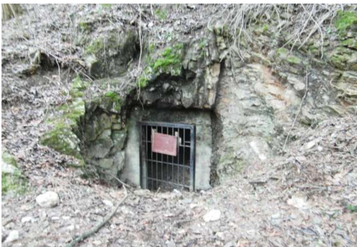
Obr. 52 Pohled na nejmenovanou štolu pod štolou Mír. Stav roku 2013.
