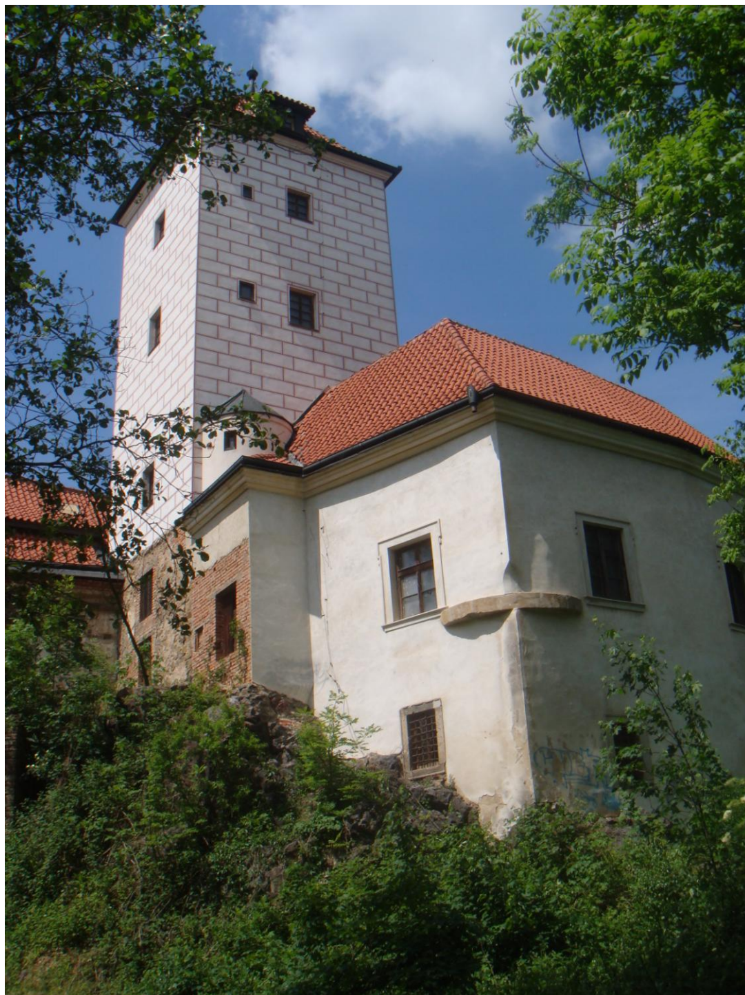
Pohled na nově opravenou věž zámku
