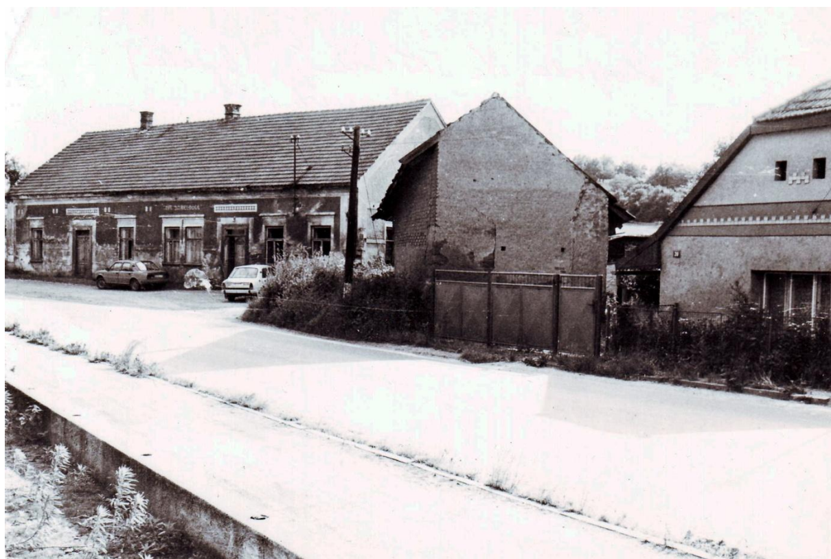
5. Nučice, bývalá cerhenická hospoda na Střelovce
