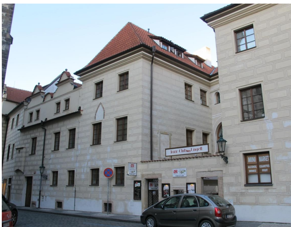
25. Praha , Staré Město, palác Granovských v Ungeltu, po 1558, snížený trakt západního křídla zakončený obnoveným renesančním štítem, pohled od jihu
