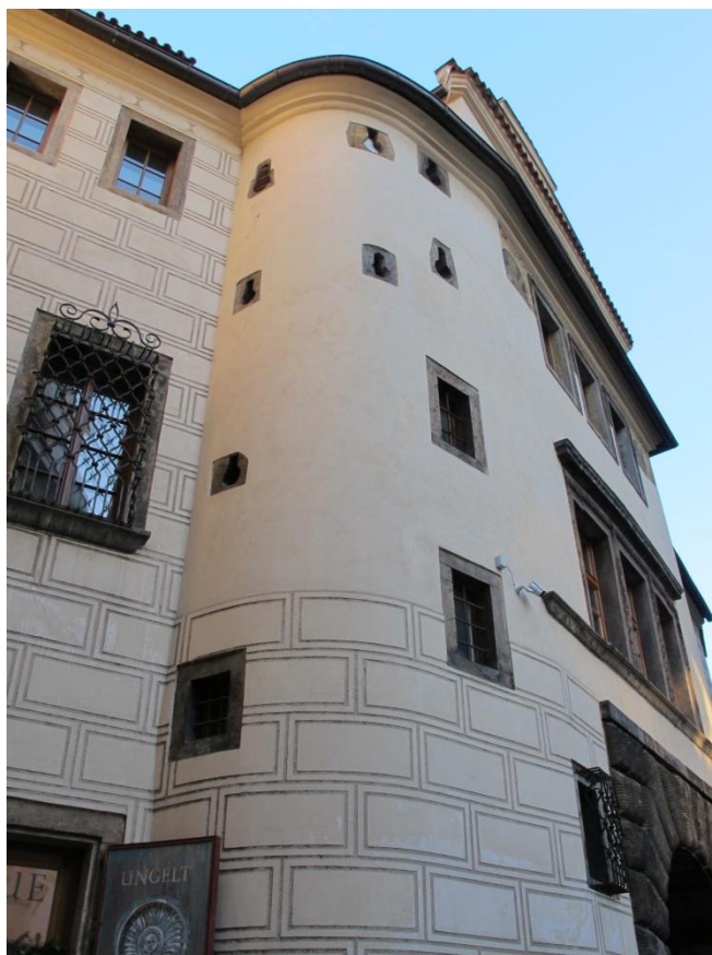
33. Praha , Staré Město, palác Granovských v Ungeltu, po 1558, vstupní rizalit, vnitřní šnekovité schodiště na severní straně rizalitu, detail
