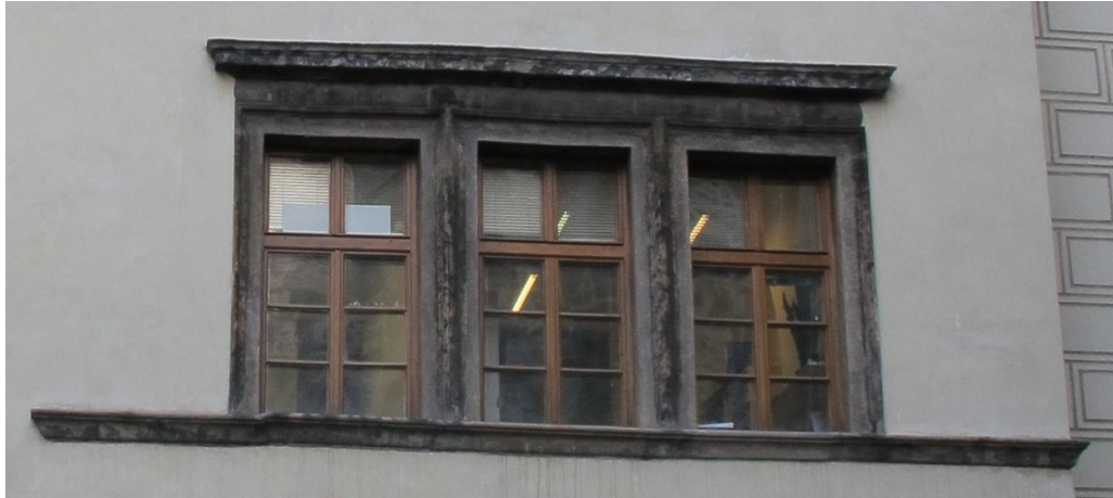
31. Praha , Staré Město, palác Granovských v Ungeltu, po 1558, střední část fasády rizalitu, detail trojice oken s profilovanou nadokenní římsou
