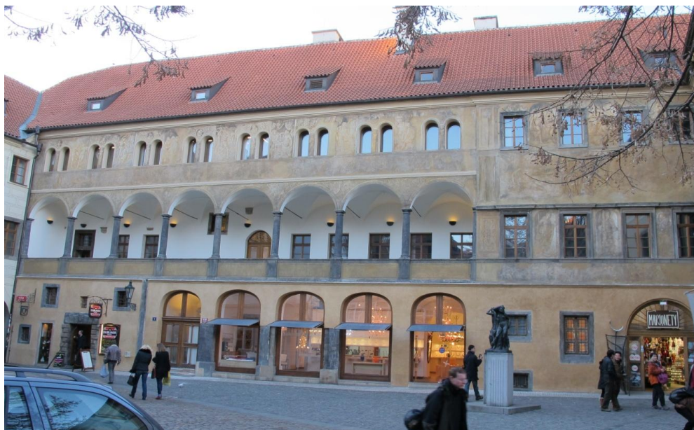
57. Praha , Staré Město, palác Granovských v Ungeltu, po 1558, severní křídlo, jižní průčelí, pohled ze dvora
