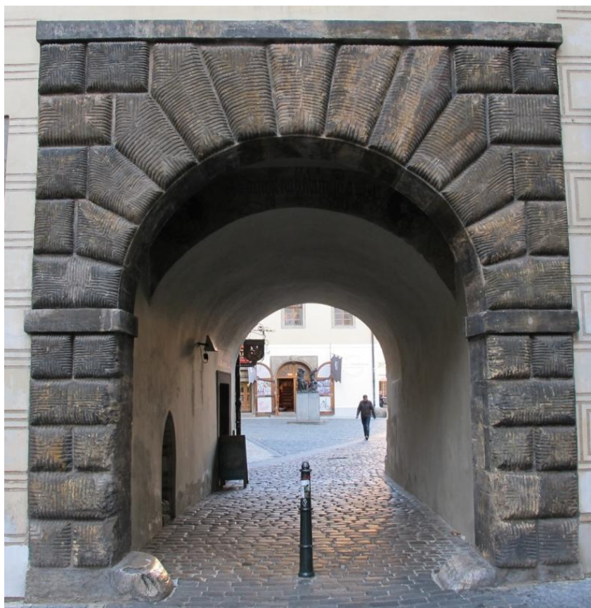
39. Praha , Staré Město, palác Granovských v Ungeltu, po 1558, bosovaný portál vstupního rizalitu
