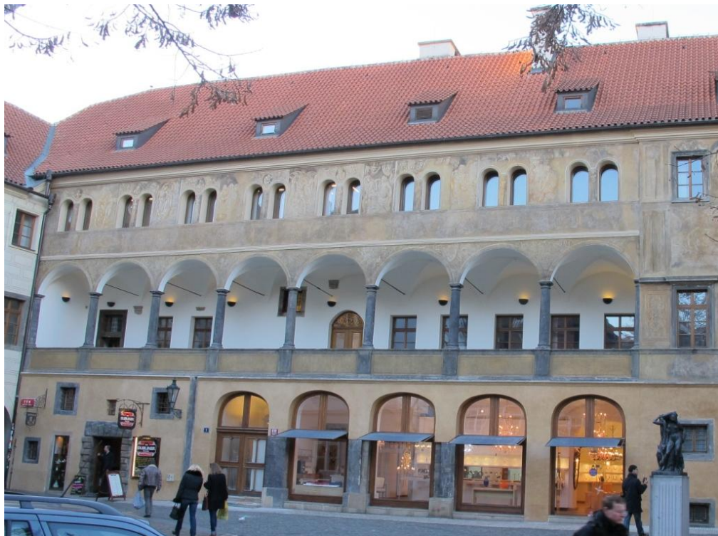
60. Praha , Staré Město, palác Granovských v Ungeltu, po 1558, severní křídlo, jižní průčelí, západní část fasády otevřená pomocí arkád
