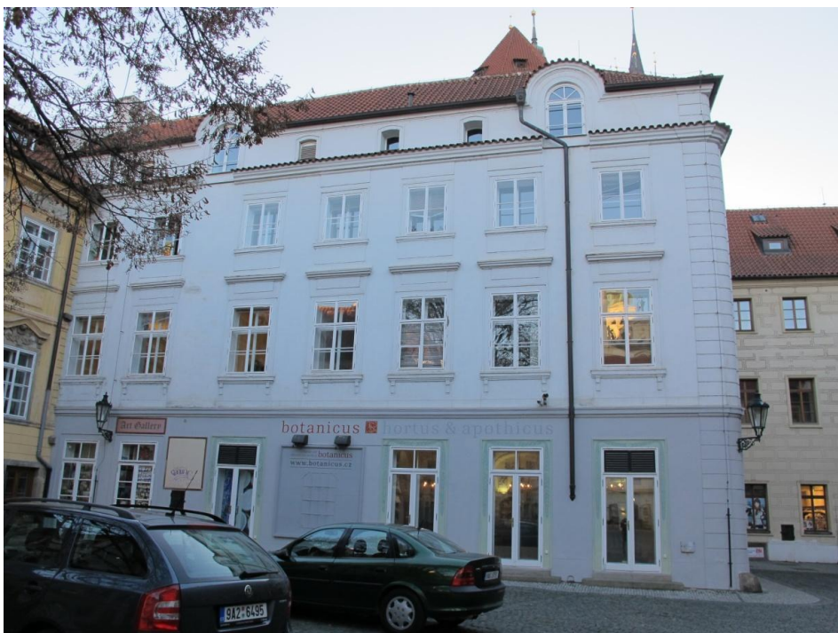
6. Praha , Staré Město, palác Granovských v Ungeltu, po 1558, dnešní dům čp. 640, pohled na nádvoří fasádu
