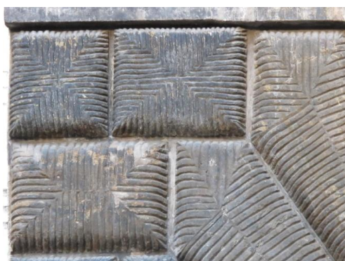
40. Praha , Staré Město, palác Granovských v Ungeltu, po 1558, bosovaný portál rizalitu, detail povrchové úpravy bosáže
