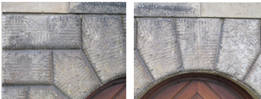
50. Praha , Pražský hrad, ulice Mariánské hradby, bosovaný portál ústící do Královské zahrady, detail povrchové úpravy bosáže
