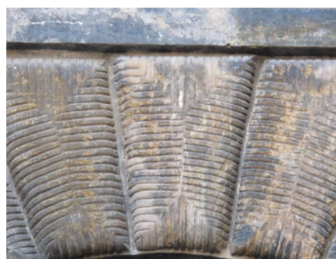
40. Praha , Staré Město, palác Granovských v Ungeltu, po 1558, bosovaný portál rizalitu, detail povrchové úpravy bosáže
