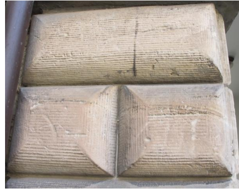
53. Nelahozeves , západní křídlo zámku, 1558/9–60. léta 16. století, bosovaný portál nárožního bastionu, pohled z nádvoří a detail povrchové úpravy bosáže
