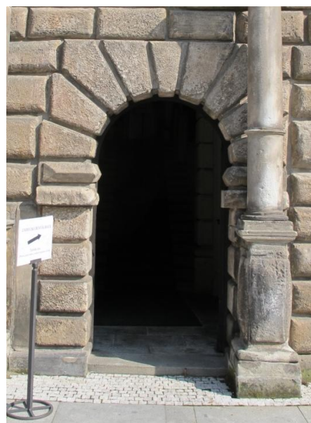
52. Nelahozeves , východní křídlo zámku, 1553–1558, vstupní portál východního křídla, pohled z nádvoří a detail otvoru vlomeného do rustiky
