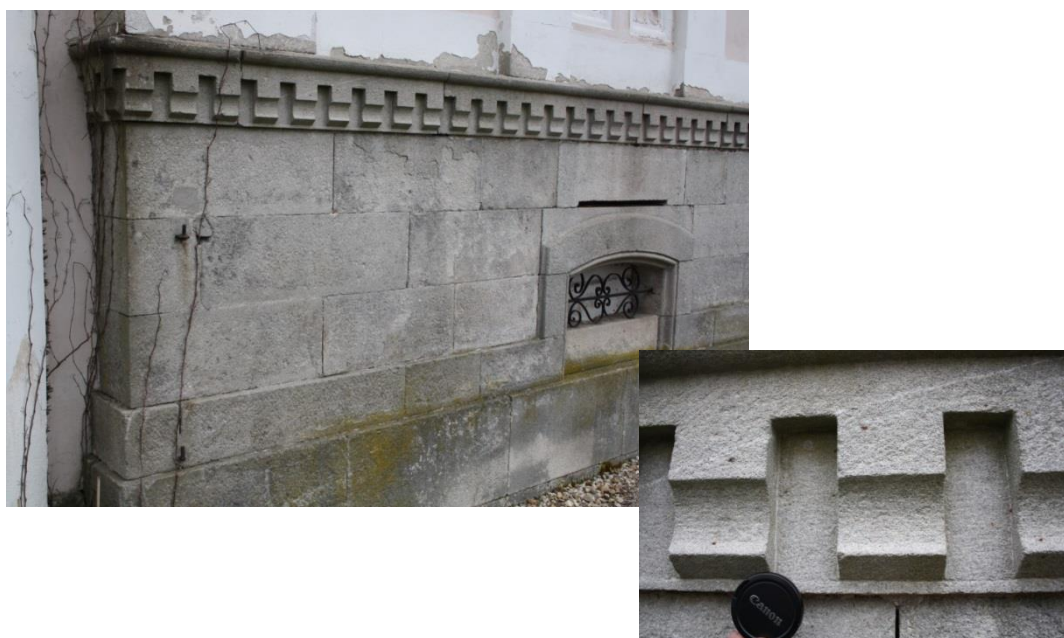
Obr. 7. Podezdívka na budově Obecního úřadu v obci Prameny.
