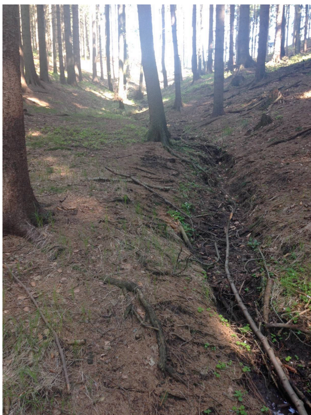
Příloha 16 Ukázka rýhy způsobené povrchovým odtokem. Povodí Vlčího potoka
