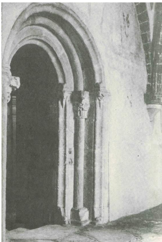
55. Strakonice, portál kapitulní síně, 1225–1230
