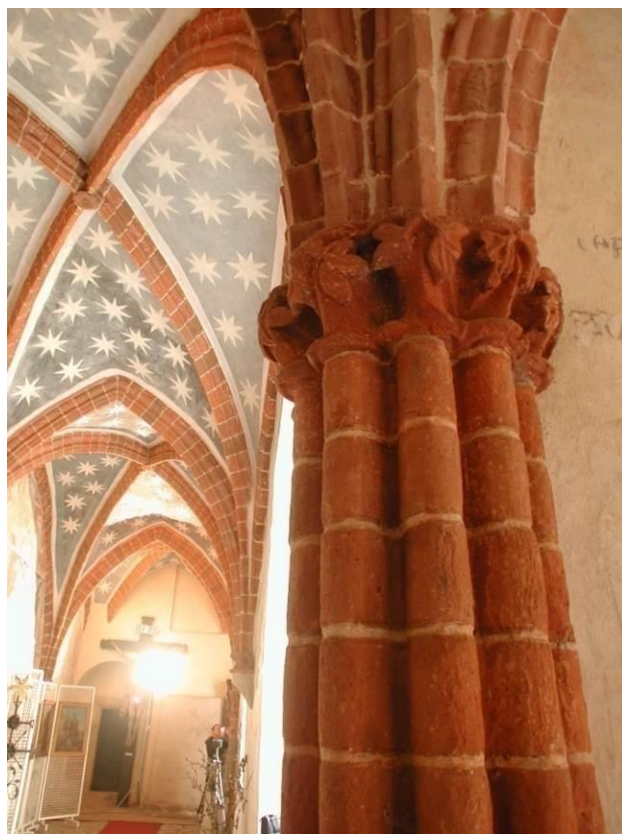
58. Strakonice, terakotové hlavice svazkových přípor ambitu, kolem roku 1280
