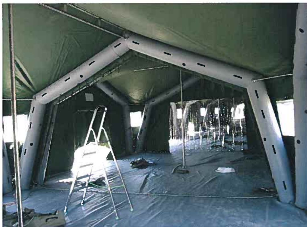
Budování nemocničního pokoje
