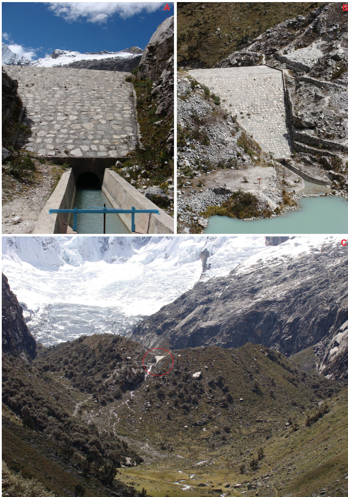
A – pohled na výtok a umělý zpevňující val směrem k jezeru; B – pohled na výtok a zpevňující val směrem od jezera; C – celkový pohled na morénovou hráz jezera Llaca, poloha výtoku a zpevňujícího valu je zvýrazněna kroužkem
