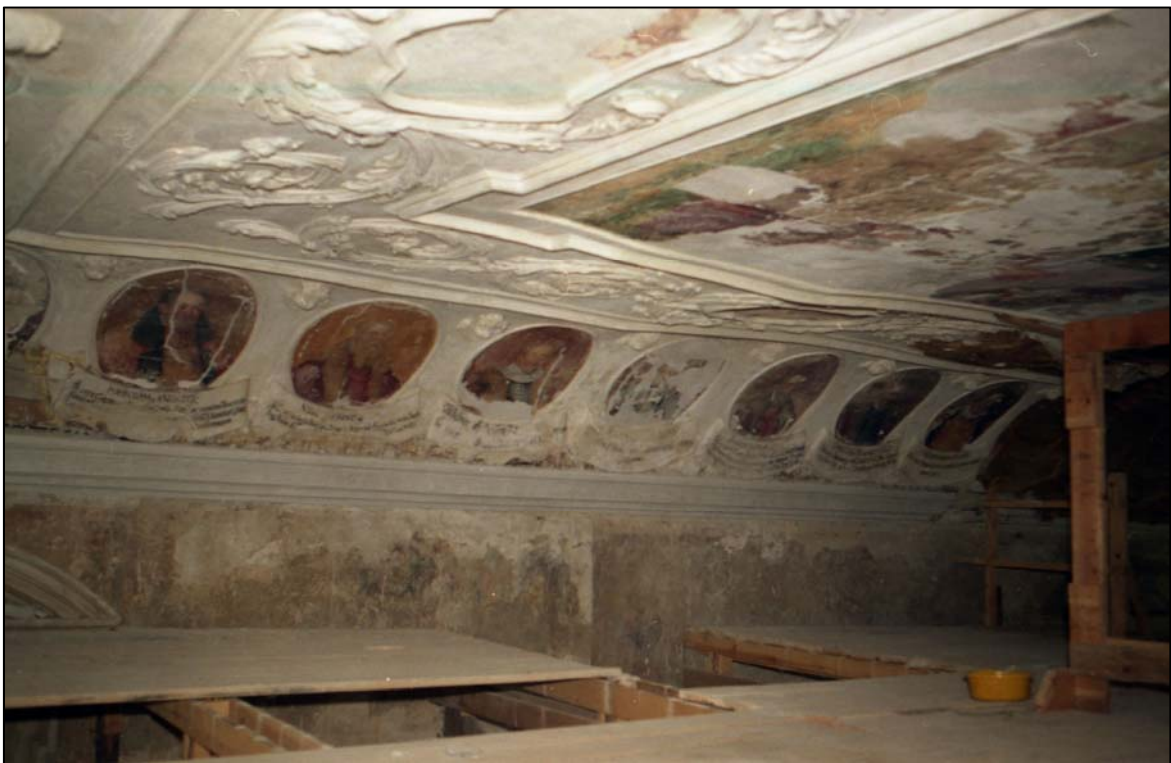
OBR. 53 Katastrofální stav výzdoby hlavního sálu zámku v Luboradzu / Lobrisu dnes (foto Dominik Kunysz).
