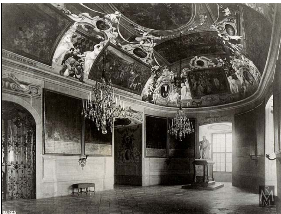
OBR. 51 Sál předků na zámku v Mikulově, stav před požárem roku 1945 (převzato z http://www.rmm.cz ).
