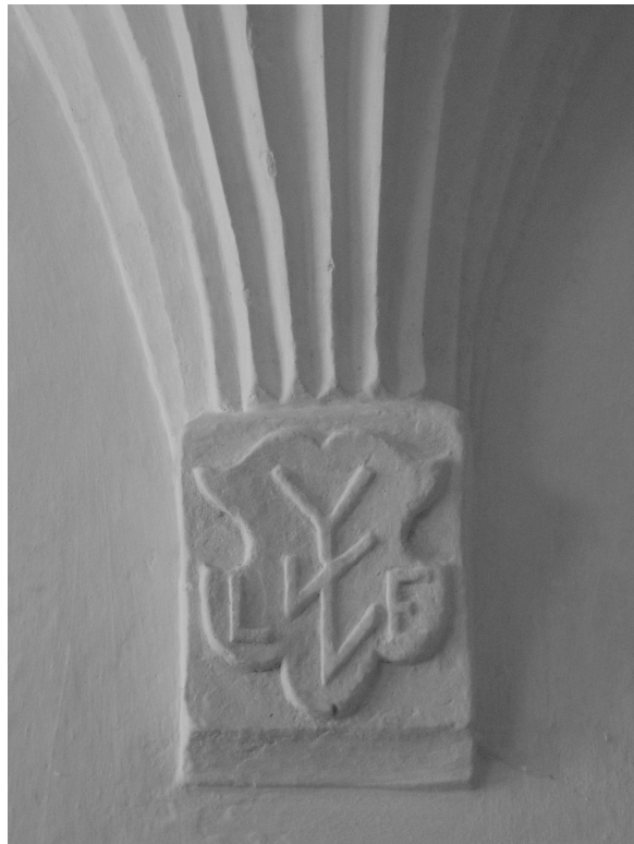
66. Sklípková klenba v domě čp. 459.
