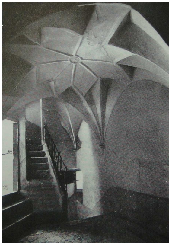
68. Klenba s krouženými hřebínky a štukovou lipovou ratolestí v domě čp. 460. 69. Sklípková klenba v domě čp. 520.
