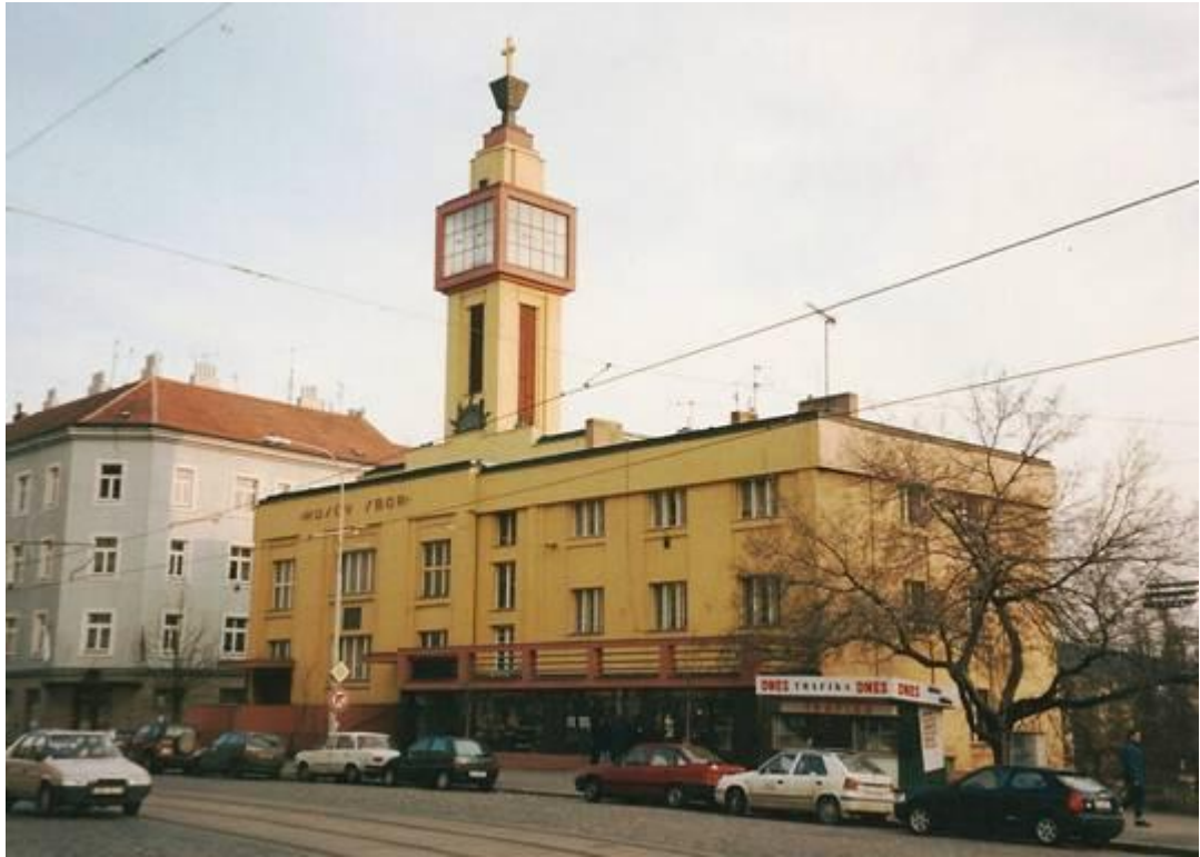
10. Karel Truksa: Husův sbor ve Vršovicích, 1930.
