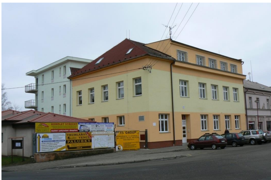
Starší část internátu – nově zrekonstruovaná část – 2 výchovné skupiny, v přízemí sekretariát, ekonomický úsek, sociální úsek a provozní úsek.
