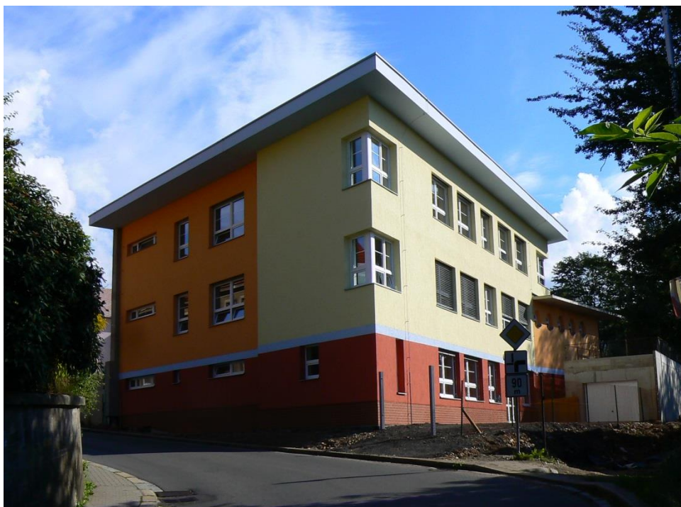
Jihozápadní pohled na budovu školy.
