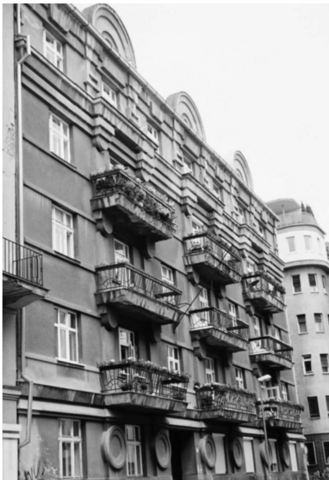
Obr 37. Klement Šilinger, Obytný dům na Heydukové ulici v Bratislavě (1922)
