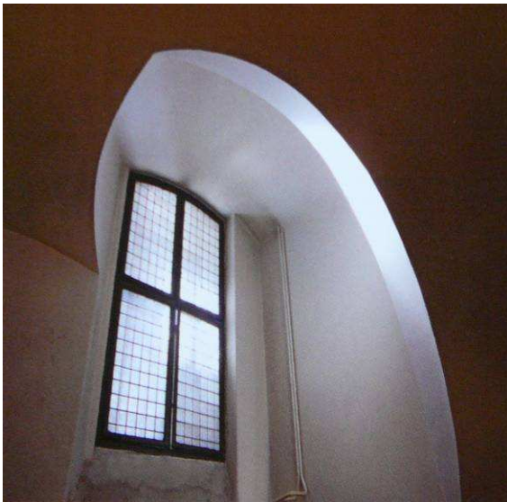
Obr. 23 Plzeňská radnice — zbytky původního vstupu do sklepních prostor
