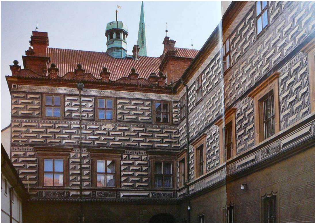
Obr. 9 Plzeňská radnice — pohled ze dvora
