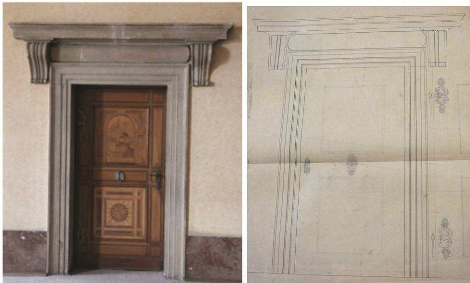
Obr. 30 Plzeňská radnice — hlavní sál, vnitřní portál (fotografie / detail dveří)
