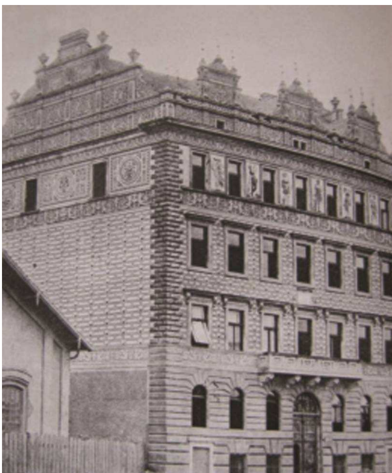
Obr. 70 Dům č. p. 94 v Sadové ulici, Praha – Vinohrady
