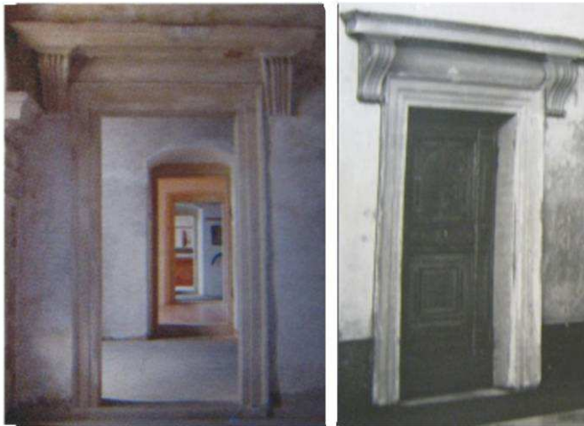
Obr. 43 Zámek v Kaceřově — vnitřní portál / plzeňská radnice — vnitřní portál
