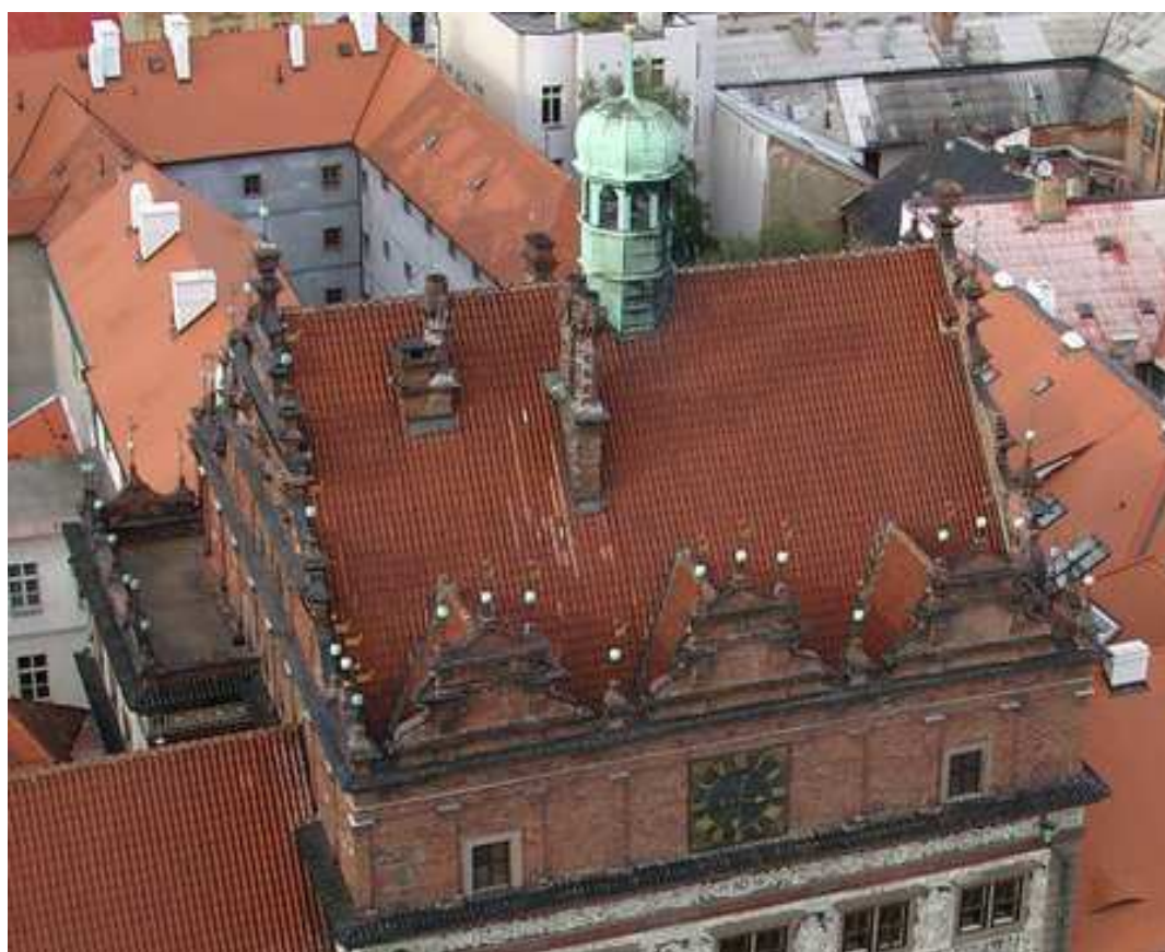
Obr. 19 Plzeňská radnice — zastřešení budovy
