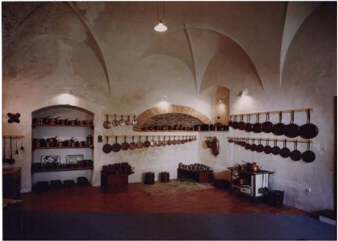
Obr. 50 Zámek v Horšovském Týně — zaklenutí vnitřních prostor
