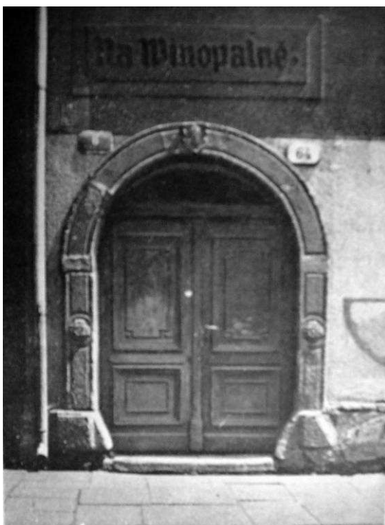
Obr. 36 Dům č. p. 64 v Perlové ulici v Plzni — vstupní portál
