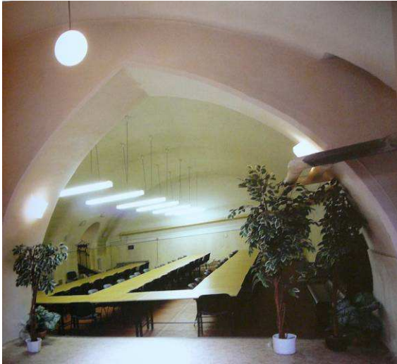
Obr. 22 Plzeňská radnice — hlavní sklepní sál s nepůvodním hrotitým obloukem
