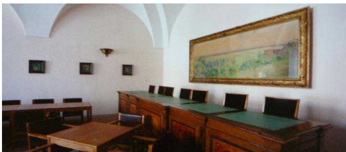
Obr. 32 Plzeňská radnice — prostor na severní straně hlavního sálu — atypické zaklenutí v rozích místnosti
