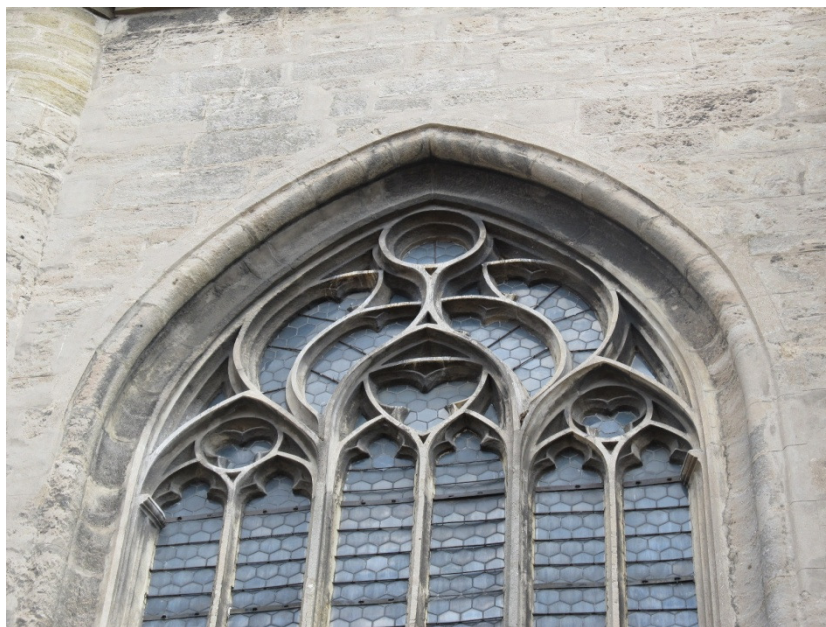
Obr. 13: 2012, Detail okna západního průčelí, konec 14.století, rekonstrukce 15.století, kostel sv. Jakuba, Kutná Hora
