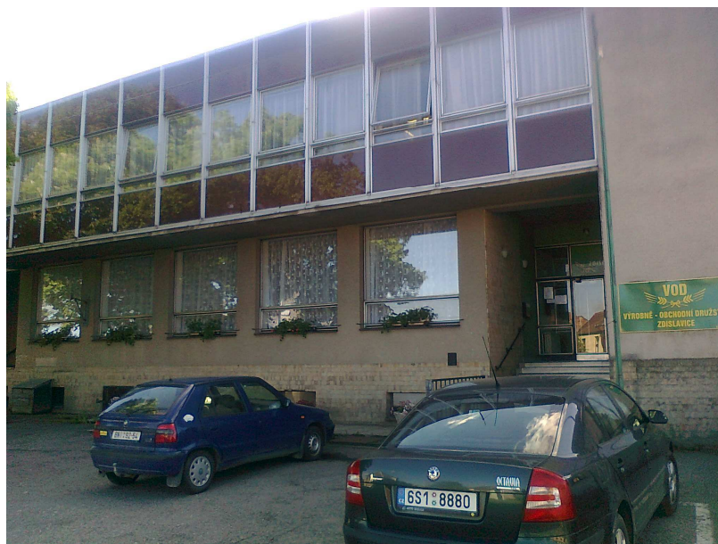
19. Kulturní dům – Zdislavice : vybudovaný JZD Zdislavice a otevřený v roce 1978. Dodnes je ve vlastnictví místního zemědělského družstva, jež má v tomto objektu kanceláře a sál, který je využíván ke společenským účelům. (Zdroj: foto – autor)
