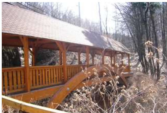
Foto č. 10: Dřevěný most
