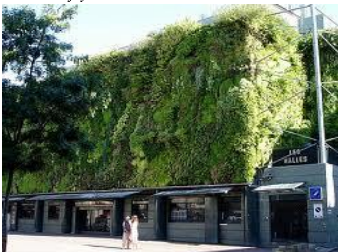
35. Krytý trh dnes.
