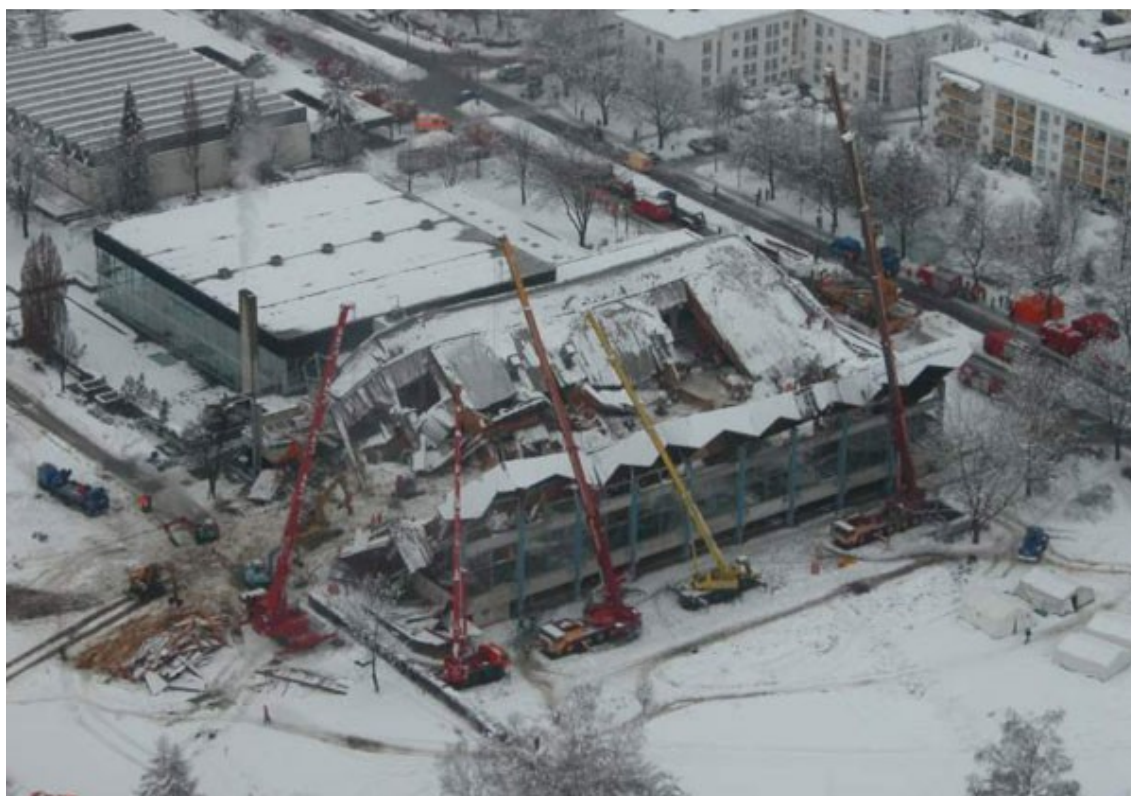
Obr. 1 - Propadnutí stropu ZS v Bad Reichenhallu
