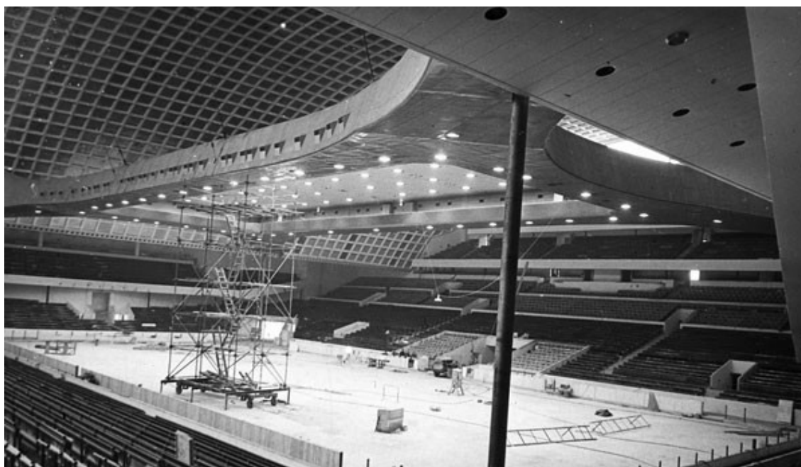
Obr. 6 - Pohled na osvětlený osvětlovací most a na část skořepiny zastřešení
