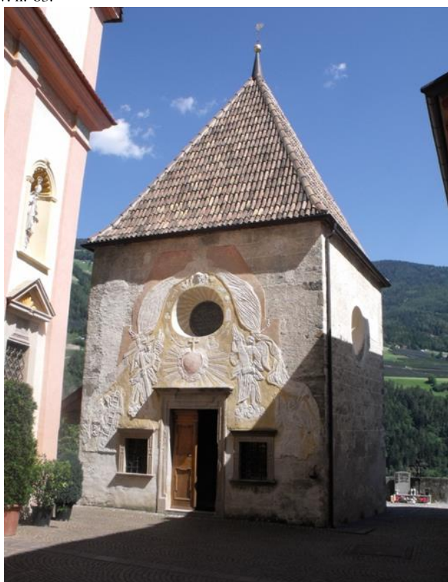
52. Rifiano , hřbitovní kaple, před 1415, pohled od severu
